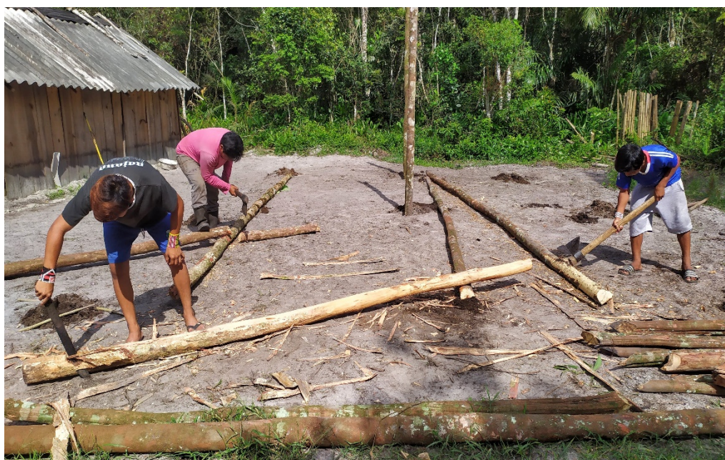
Figura 33. Descascando a madeira/ Jabuticabeira/foto de Hugo Kara/ 2019
