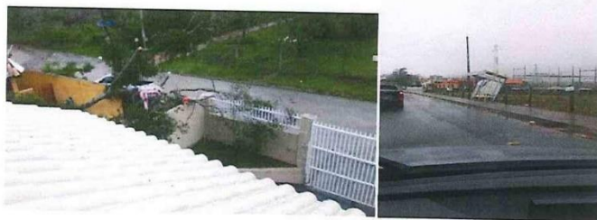
Árvores caídas e vários pontos de ônibus tombados;
