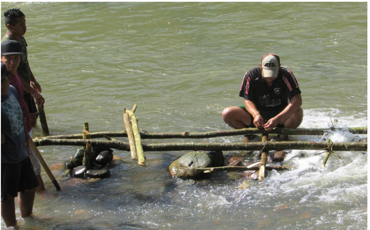
Figura 15: Construção da escora onde será colocada a armadilha. Fonte: Arquivo Paola Gibram.
