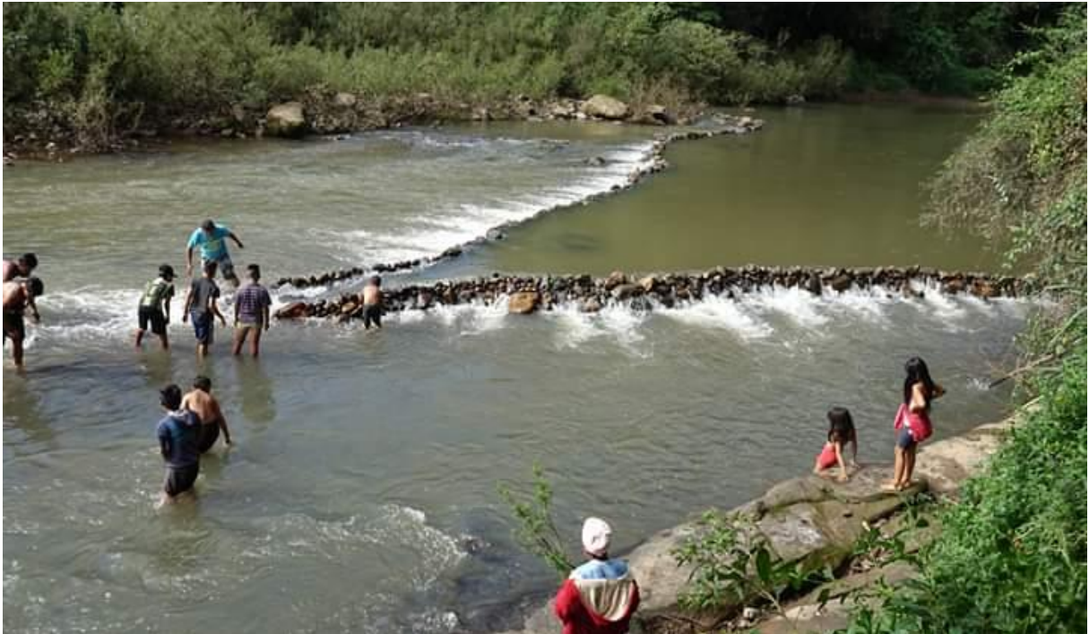
Figura 14: Construção do dique de contenção ( prũg ). Fonte: Arquivo Paola Gibram.
