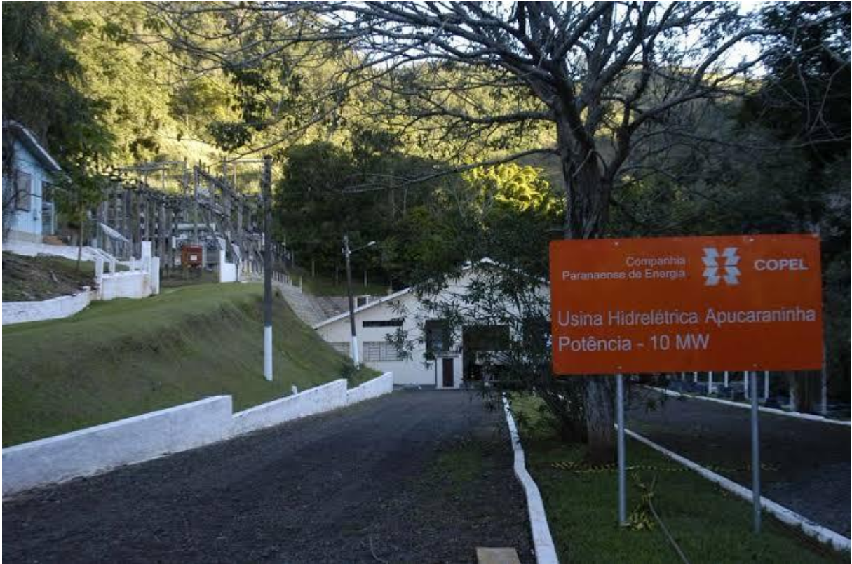
Figura 2: Entrada da Usina Hidrelétrica Apucarantina.
