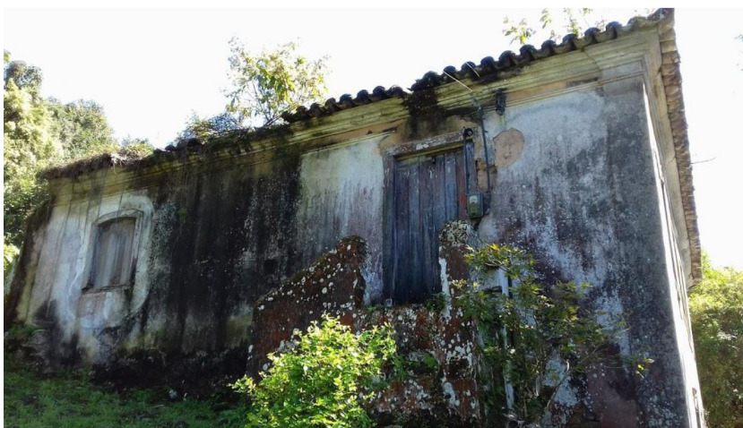
Figura 18: Casarão da Dona Loquinha - Fachada Lateral Sul - situação atual
