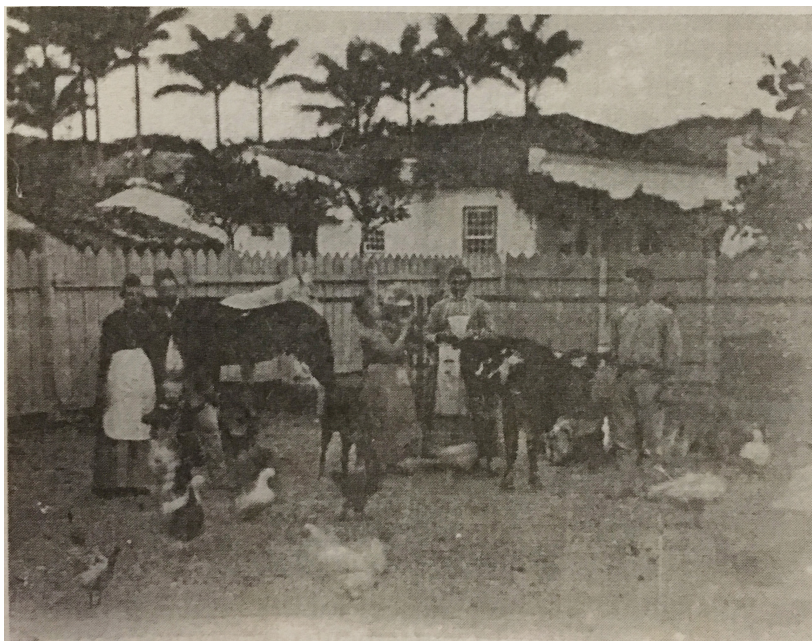
Figura 15: Quintal de uma casa na Praia de Fora (próximo à Praça Esteves Júnior – Beira-mar norte)
