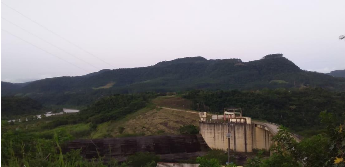
Figura 9- Barragem Norte. Foto da autora, 7 de janeiro 2020.
