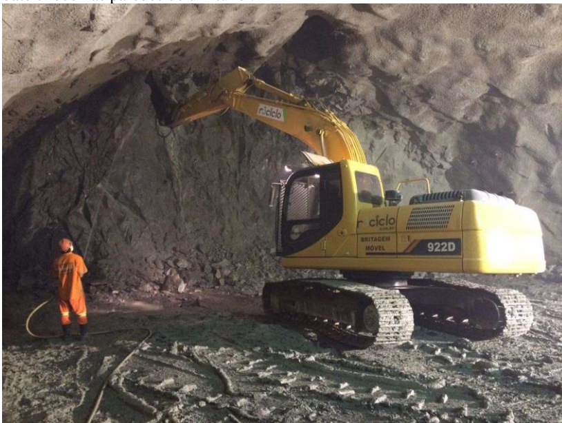
Figura 41 - Escavadeira com martelo hidráulico realizando o procedimento de bate choco nas paredes de um túnel.
