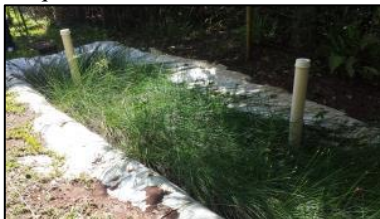
Figura 28- Wetland Construído no Parque Estadual Fritz Plaumann.
