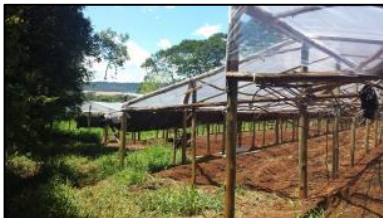
Figura 8- Coleta da água pluvial pelas calhas das leiras de cultivo orgânico protegido na propriedade do Sr. Olidemar Antônio Luzzi.
