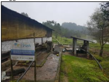
Figura 20– Unidade de recebimento e bombeamento dos dejetos suínos da propriedade do Sr. Valdir Wiggers.
