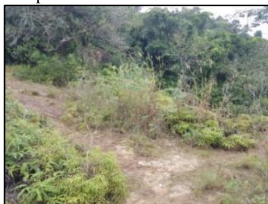
Figura 17– Contenção de taludes da Escola Prof. Donato Alípio de Campos.
