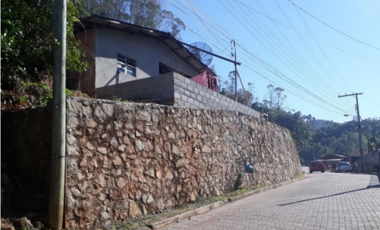
Figura 13 - Muro de Contenção, rua: Francisco Pereira Silva (2018).
