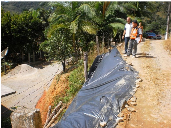
Figura 19 – Rua: Lauro Manoel de Souza, Colônia Santana, deslizamento em residência.
