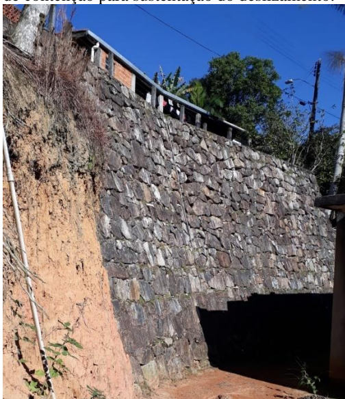
Figura 20 - Rua: Lauro Manoel de Souza, Colônia Santana, construção do muro de contenção para sustentação do deslizamento.
