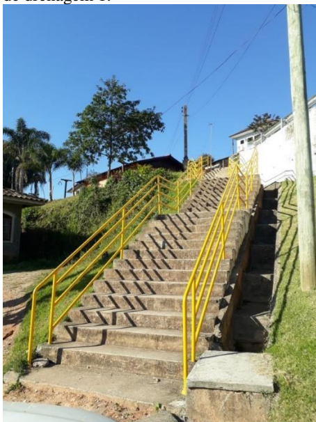
Figura 14 - Rua: Romalino Cunha, Colônia Santana, obra da escada com sistema de drenagem 1.
