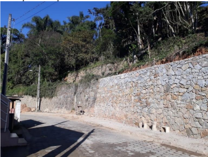
Figura 17 - Rua Cecília São Piai, Colônia Santana, construção de muro de contenção em via pública.
