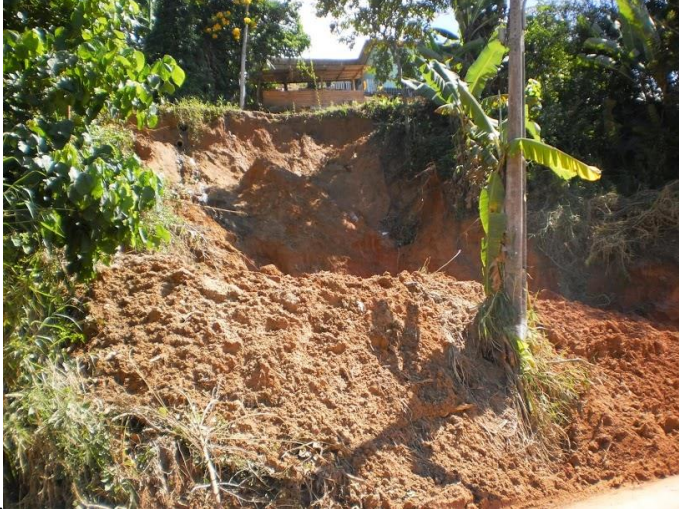
Figura 16 – Rua Cecília São Piai, Colônia Santana, deslizamento em via pública
