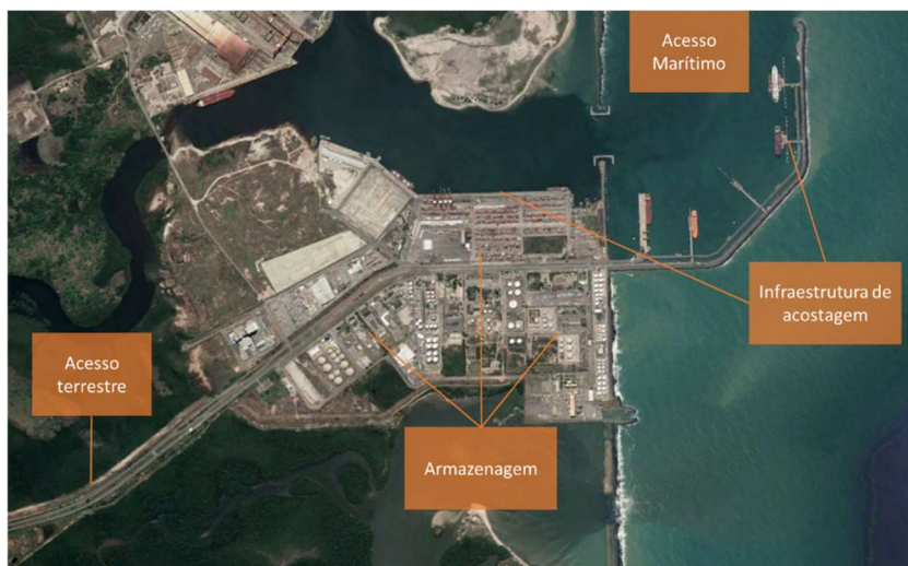
Figura 14 – Conjuntos de infraestrutura operacional portuários – Exemplo de Suape (PE)
