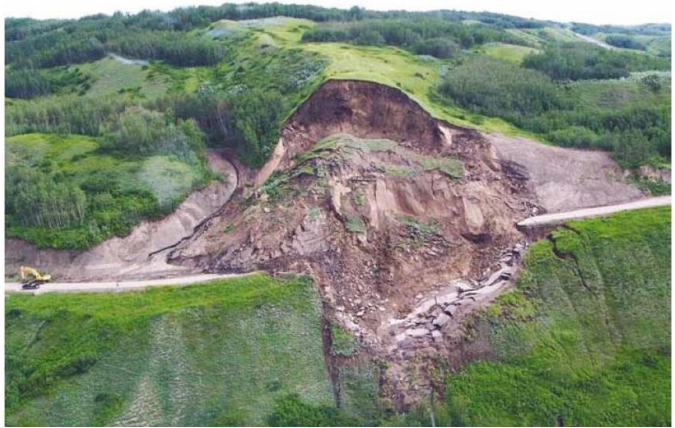
Figura 09: Imagem de um escorregamento translacional que ocorreu em 2001 no Vale do Rio Beaton, British Columbia, Canada. (Fotografia por Réjean Couture, Canada Geological Survey). Fonte: Manual de Deslizamento – USGS, 2008.
