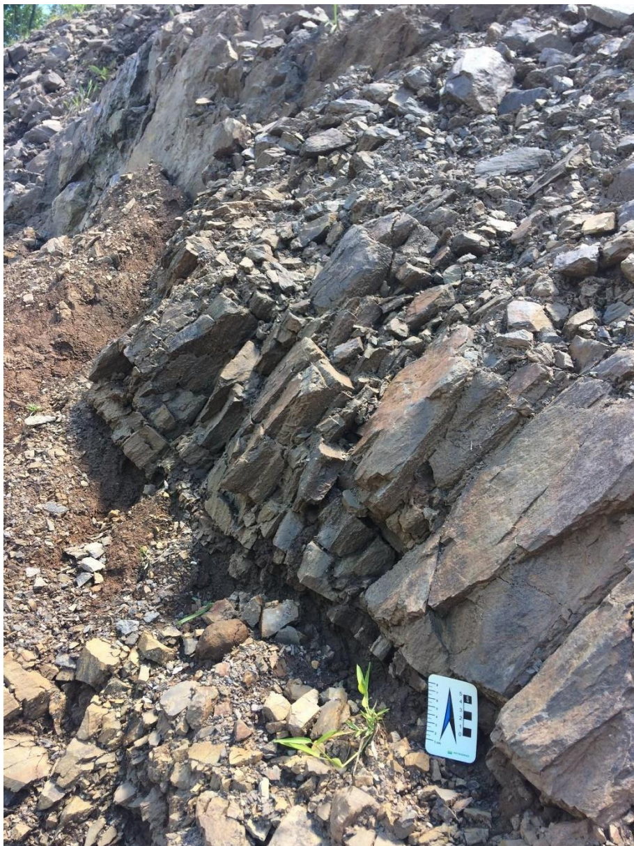
Figura 65: Foto da encosta com os arenitos expostos, detalhe para o plano das camadas verticalizado na mesma direção do deslizamento.
