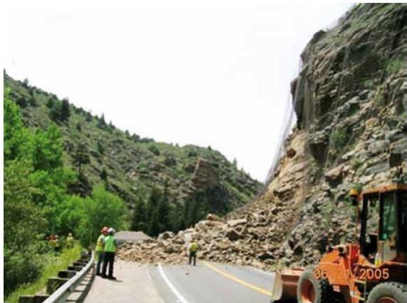
Figura 03: Queda rochosa e deslizamento ocorrido em Clear Creek Canyon, Colorado, EUA, em 2005, fechando o trânsito no canyon por várias semanas. A fotografia também mostra um exemplo de uma parede de pedras (cortina), um tipo de barreira comumente aplicado sobre faces rochosas de risco (centro e direita da foto). (Foto por Colorado Geological Survey). Fonte: Manual de Deslizamento – USGS, 2008.
