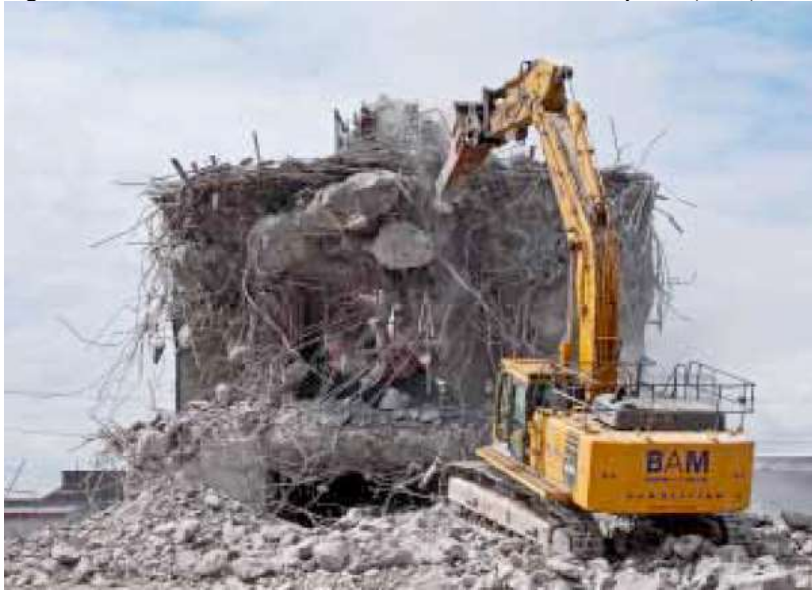
Figura 14 – Descomissionamento da estrutura da casa de máquinas (2014).
