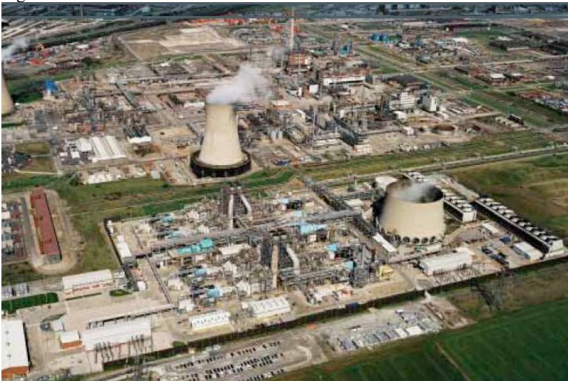
Figura 11 – Vista aérea Teesside Power Station em 2004.
