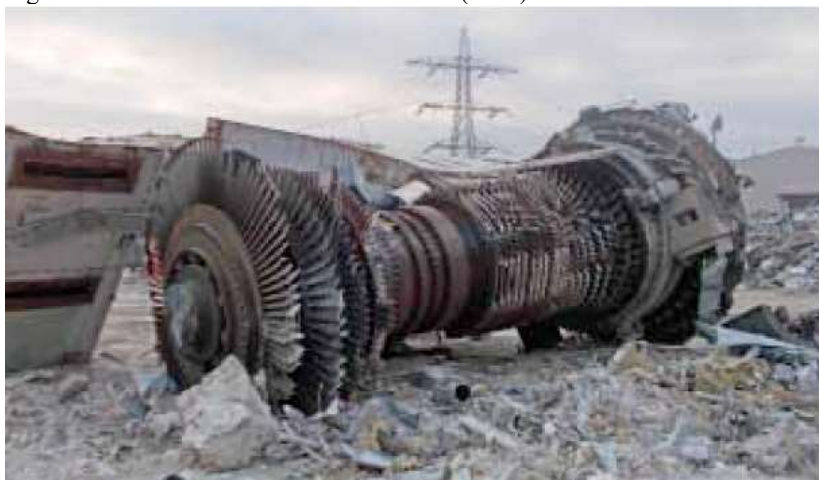
Figura 13 – Descomissionamento da turbina (2014).
