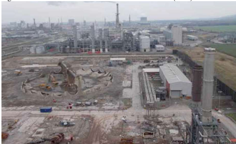
Figura 12 – Descomissionamento da torre de resfriamento (2014).
