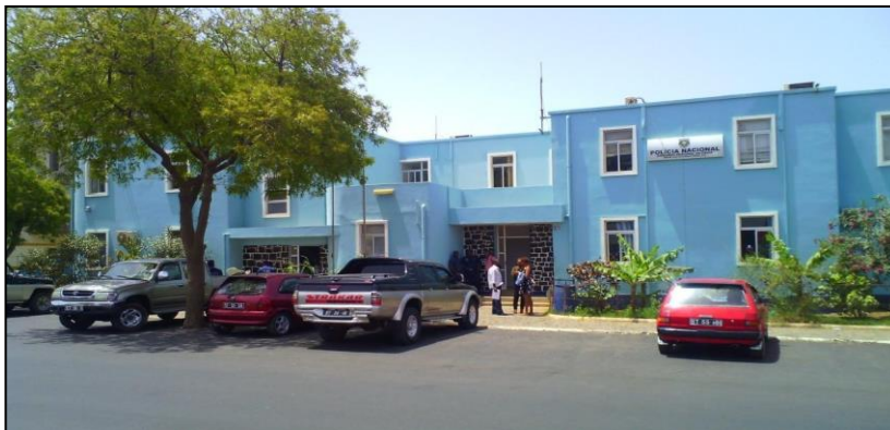
Figura 4 - Edifício do Comando Regional da Praia – Esquadra da Polícia Nacional de Achada Santo Antônio.
