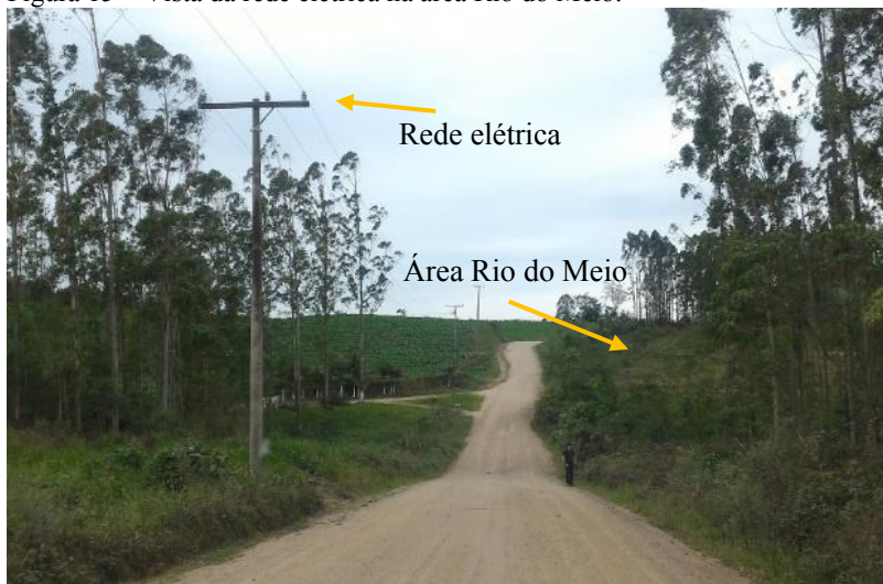
Figura 15 – Vista da rede elétrica na área Rio do Meio.
