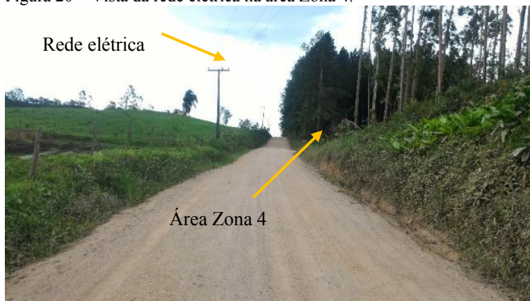
Figura 20 – Vista da rede elétrica na área Zona 4.
