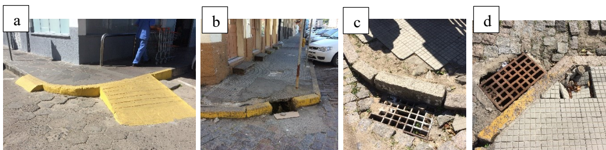
Figura 73 Desníveis considerados na contagem, cruzamentos entre calçadas.
