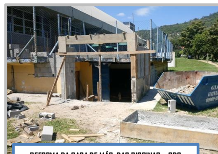
REFORMA DA CASA DE MÁQ. DAS PISCINAS - CDS
