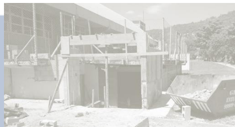
Reforma da casa de máquinas das piscinas – CDS
