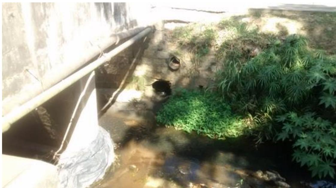
Figura 12: Resíduos acumulados na entrada da seção da ponte da Rua Delfino Conti (vista a partir da margem esquerda). (CGA/UFSC, 25/11/2019).
