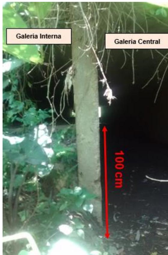
**Figura 30:** Vista de jusante para montante da seção de passagem do Rio do Meio sob Av. Prof. Henrique Fontes. Detalhe do acúmulo de sedimentos dentro da galeria interna a ser removido completamente. (CGA/UFSC, 25/11/2019).
