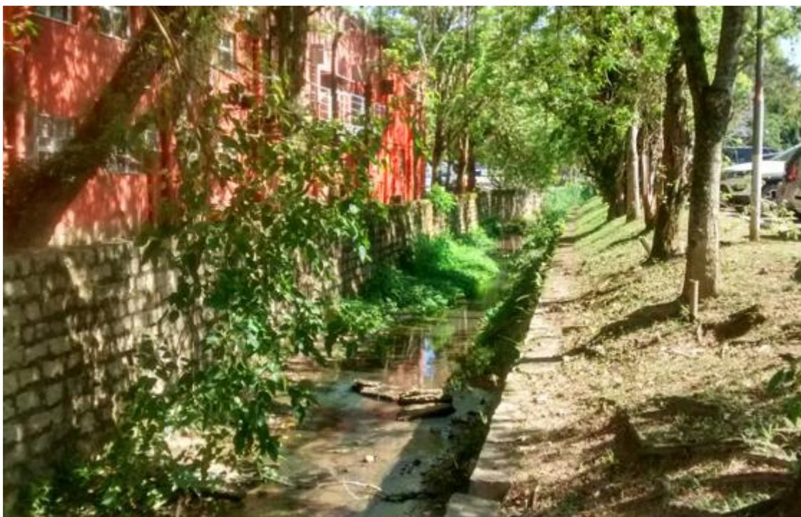
Figura 38: Acúmulo de sedimentos e crescimento de vegetação entre Reitoria I e Bloco B da Engenharia Mecânica. Remoção de sedimentos no trecho não é necessária. Excessos serão monitorados. (CGA/UFSC, 25/11/2019).
