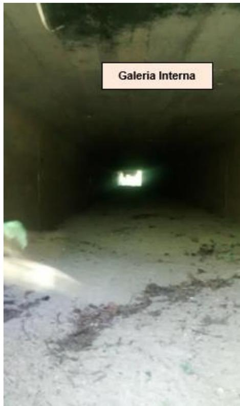
Figura 29: Vista de jusante para montante da seção de passagem do Rio do Meio sob Av. Prof. Henrique Fontes. Detalhe do acúmulo de sedimentos dentro da galeria interna a ser removido completamente. (CGA/UFSC, 25/11/2019).
