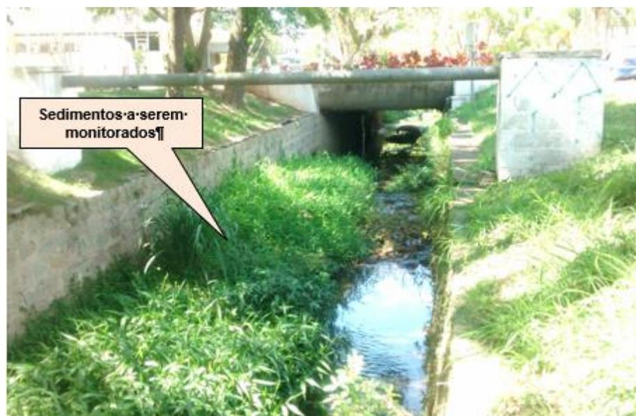
Figura 31: Acúmulo de sedimentos a ser monitorado à montante da seção da ponte do Centro de Eventos. (CGA/UFSC, 25/11/2019).
