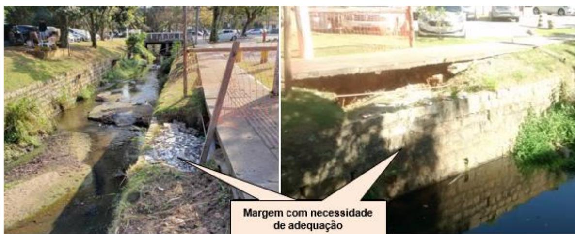
Figura 7: Seção do Rio do Meio no estacionamento do CTC com necessidade emergencial de execução de muro de arrimo em gabião. (DMPI/UFSC, 2019 e CGA/UFSC, 25/11/2019).
