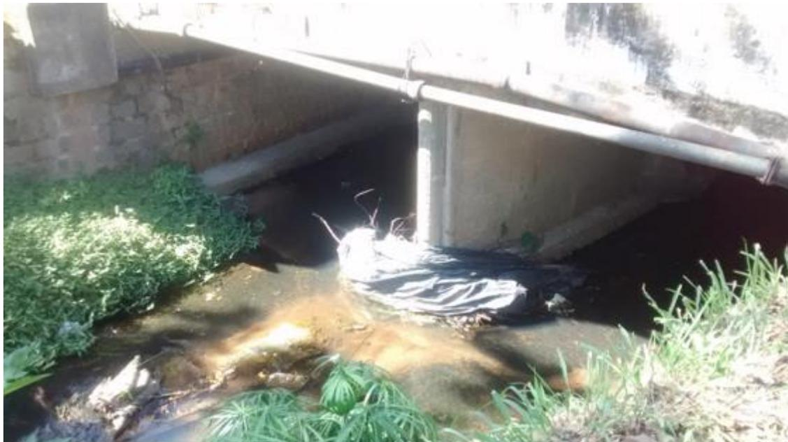
Figura 11: Resíduos acumulados na entrada da seção da ponte da Rua Delfino Conti (vista a partir da margem direita). (CGA/UFSC, 25/11/2019).
