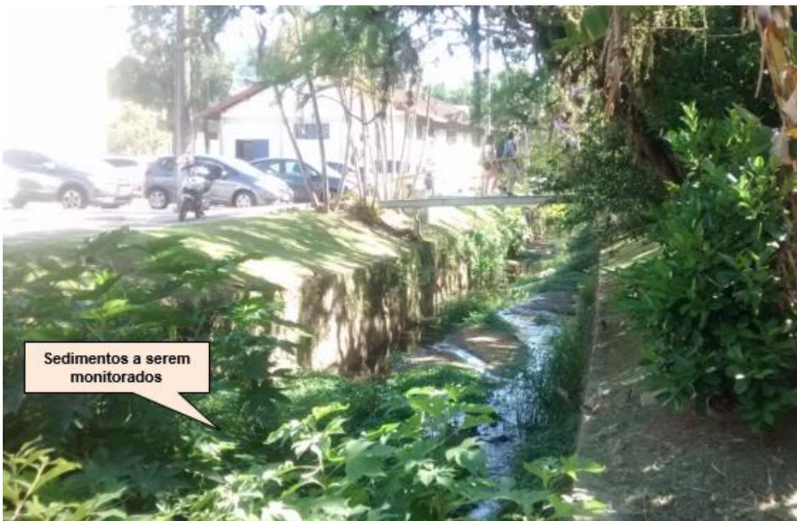
Figura 14: Acúmulo de sedimentos e vegetação à montante da seção da ponte na Rua Delfino Conti a ser monitorado, na confluência do Rio do Meio com Córrego da Carvoeira. (CGA/UFSC, 25/11/2019).
