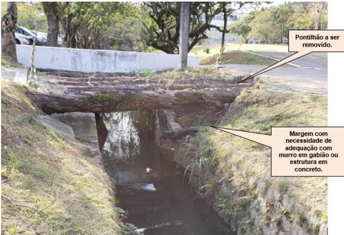
**Figura 9: Pontilhão em madeira a ser removido e adequação de margem necessária.**
