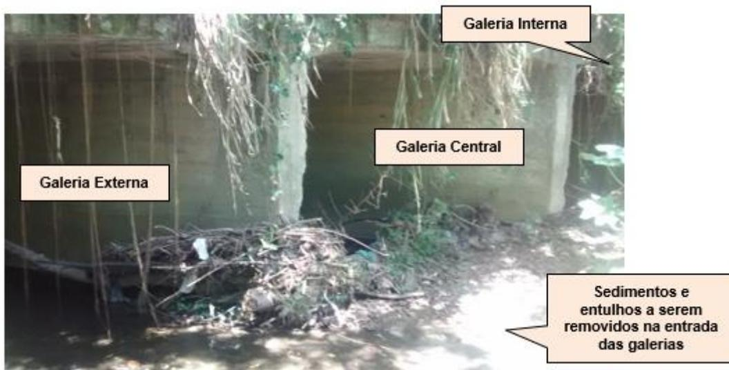
Figura 24: Sedimentos a serem removidos na entrada das galerias. (CGA/UFSC, 25/11/2019).
