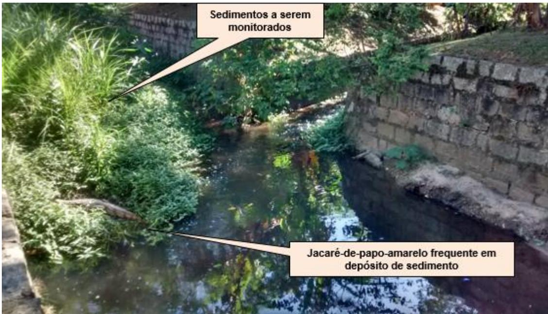
Figura 13: Acúmulo de sedimentos e vegetação à montante da seção da ponte na Rua Delfino Conti a ser monitorada, na confluência do Rio do Meio com Córrego da Carvoeira. Detalhe da presença de Jacaré-de-papo-amarelo frequente na zona de acumulação. (CGA/UFSC, 25/11/2019).
