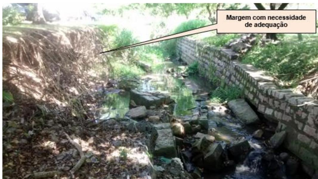
Figura 8: Seção do Rio do Meio fundos da piscina do Centro de Desportos com necessidade emergencial de execução de muro de arrimo em gabião, ou técnicas de engenharia ambiental fluvial. (CGA/UFSC, 25/11/2019).
