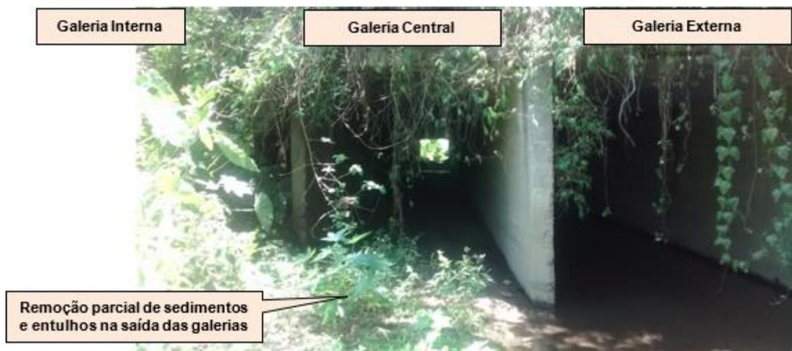
Figura 27: Vista de jusante para montante da seção de passagem do Rio do Meio sob Av. Prof. Henrique Fontes. Detalhe do acúmulo de sedimentos na saída da galeria interna a ser removido parcialmente. (CGA/UFSC, 25/11/2019).
