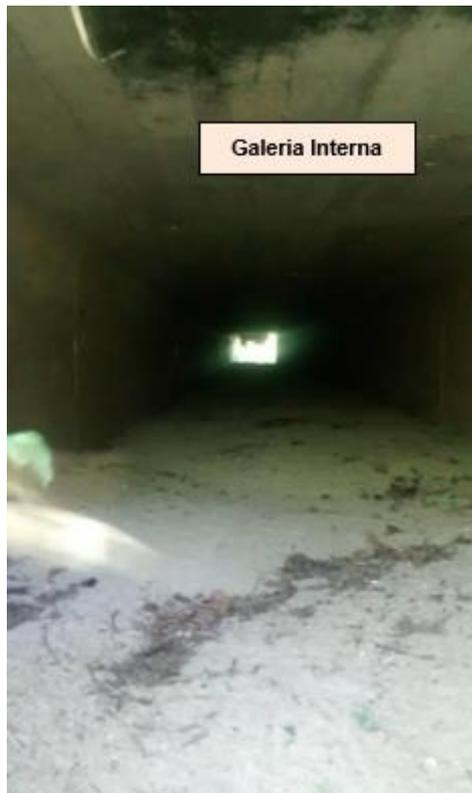
**Figura 29:** Vista de jusante para montante da seção de passagem do Rio do Meio sob Av. Prof. Henrique Fontes. Detalhe do acúmulo de sedimentos dentro da galeria interna a ser removido completamente. (CGA/UFSC, 25/11/2019).
