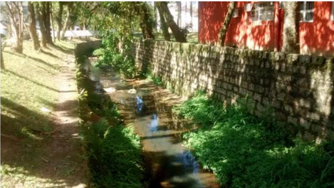
**Figura 40:** Acúmulo de sedimentos e crescimento de vegetação entre Reitoria I e Bloco B da Engenharia Mecânica. Remoção de sedimentos no trecho não é necessária. Excessos serão monitorados. (CGA/UFSC, 25/11/2019).
