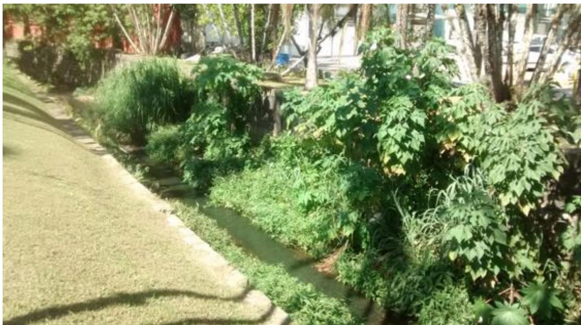
Figura 37: Acúmulo de sedimentos e crescimento de vegetação entre Reitoria I e Bloco B da Engenharia Mecânica. Remoção de sedimentos no trecho não é necessária. Excessos serão monitorados. (CGA/UFSC, 25/11/2019).
