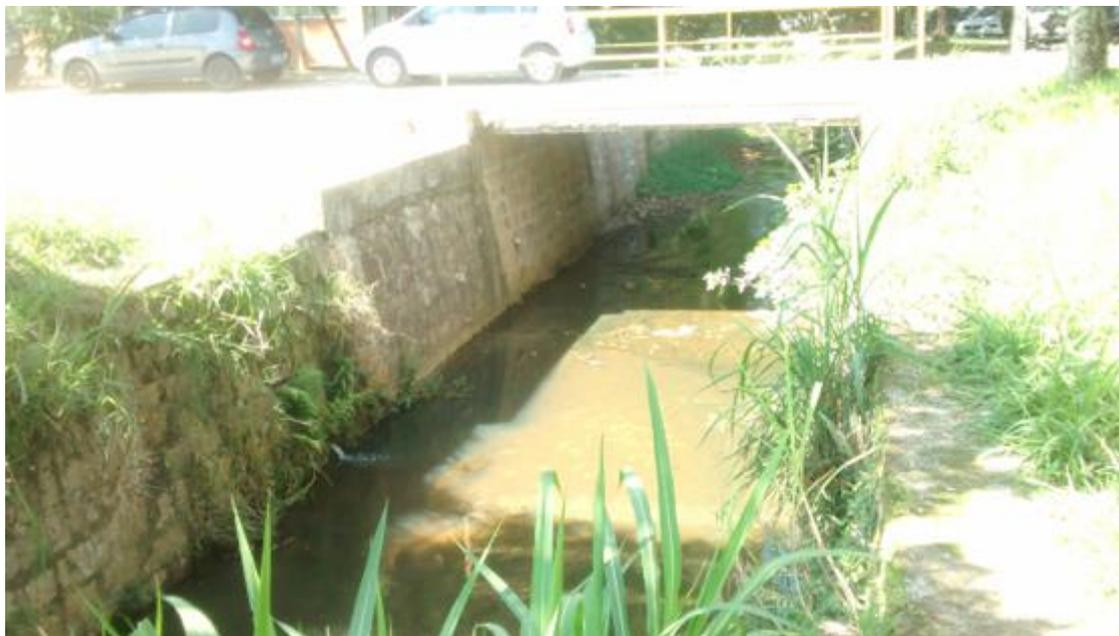
Figura 33: Acúmulo de sedimentos a ser monitorado à montante da seção da ponte da Editora da UFSC. (CGA/UFSC, 25/11/2019).
