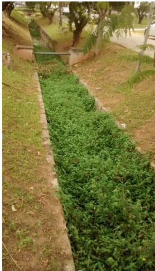
**Figura 42:** Vegetação no Córrego da Civil. O represamento total da água é desaconselhável, bem como a remoção total da vegetação. Deve-se garantir um fluxo mínimo. (CGA/UFSC, 24/11/2019).
