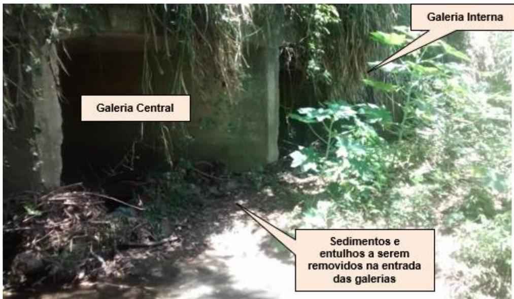
Figura 25: Sedimentos a serem removidos na entrada das galerias. (CGA/UFSC, 25/11/2019).
