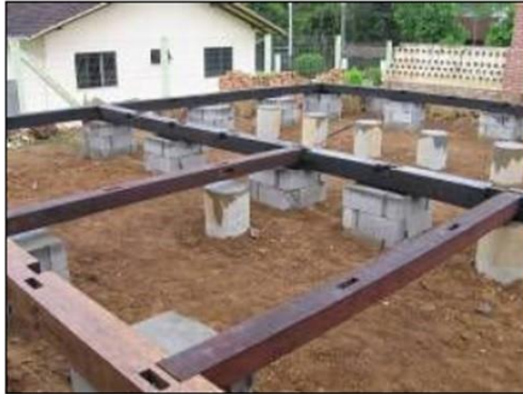
Figura 21 – Os alicerces da construção enxaimel
