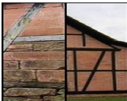
Figura 25– Detalhes dos encaixes e da superfície de uma construção enxaimel
