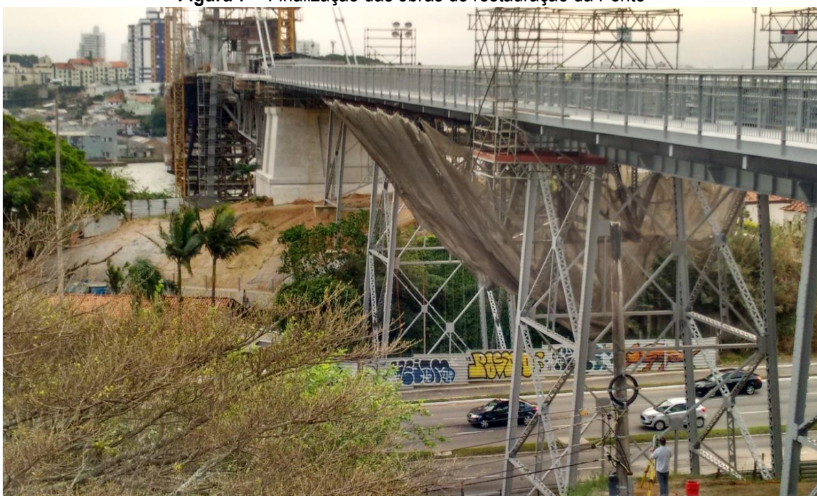
Figura 7 – Finalização das obras de restauração da Ponte
