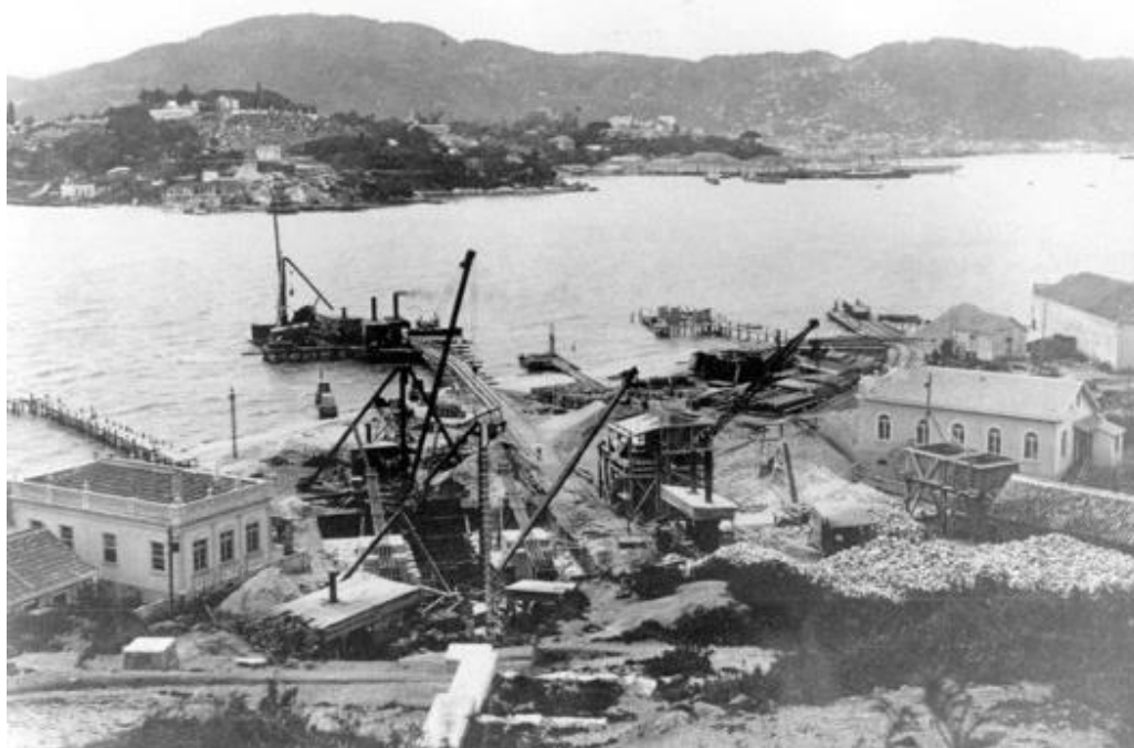
Figura 1 – Canteiro de obras da construção da Ponte em 1922.
