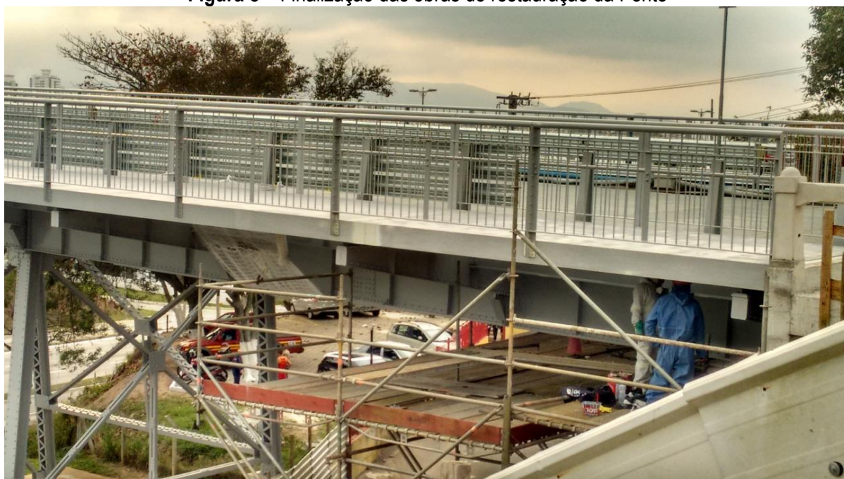
Figura 8 – Finalização das obras de restauração da Ponte
