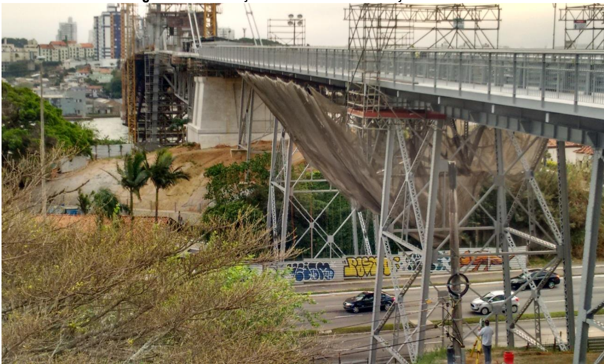
Figura 7 – Finalização das obras de restauração da Ponte
