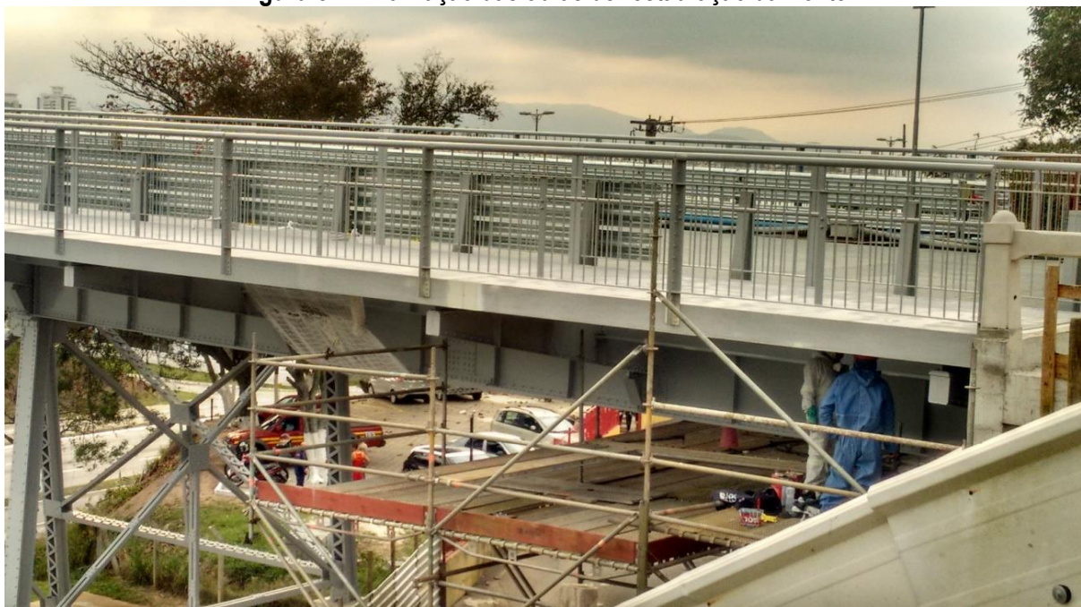
Figura 8 – Finalização das obras de restauração da Ponte
