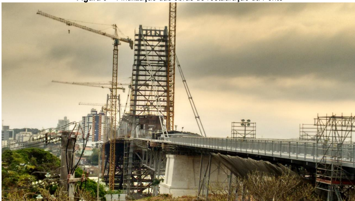
Figura 9 – Finalização das obras de restauração da Ponte
