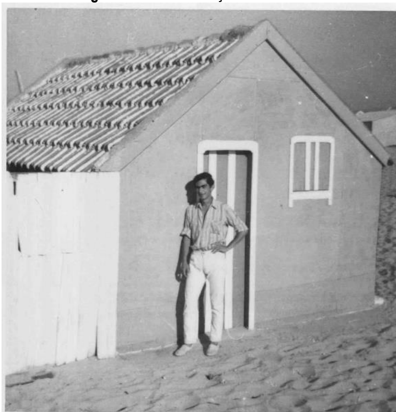
Figura 2 – Autoconstruções em alvenaria
