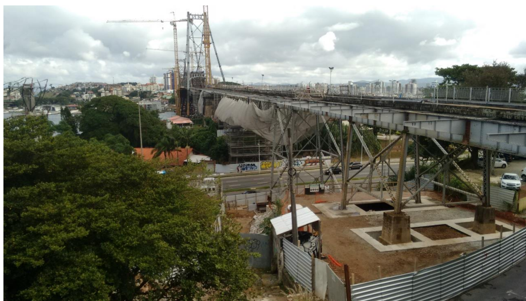
Figura 5 - Obras de restauração da Ponte Hercílio Luz em 2018.
