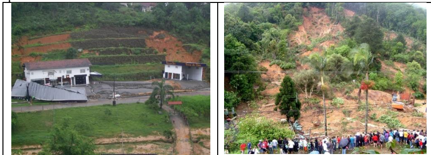
Figura 1. Escorregamentos em área urbana do município de Blumenau no episódio de novembro de 2008.
