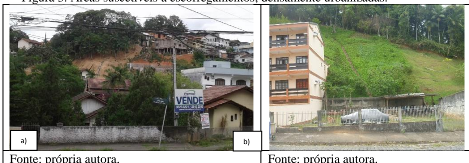
Figura 3. Áreas suscetíveis a escorregamentos, densamente urbanizadas.
