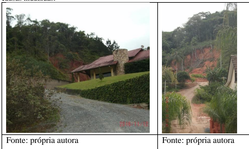
Figura 25. Ocorrências de escorregamentos rotacionais do tipo desencadeado por causas induzidas.
