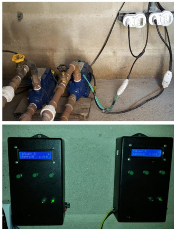
Figura 27 - Aparatos para medição de vazões afluentes aos WCV-FS (à esquerda) e WCV (à direita).
