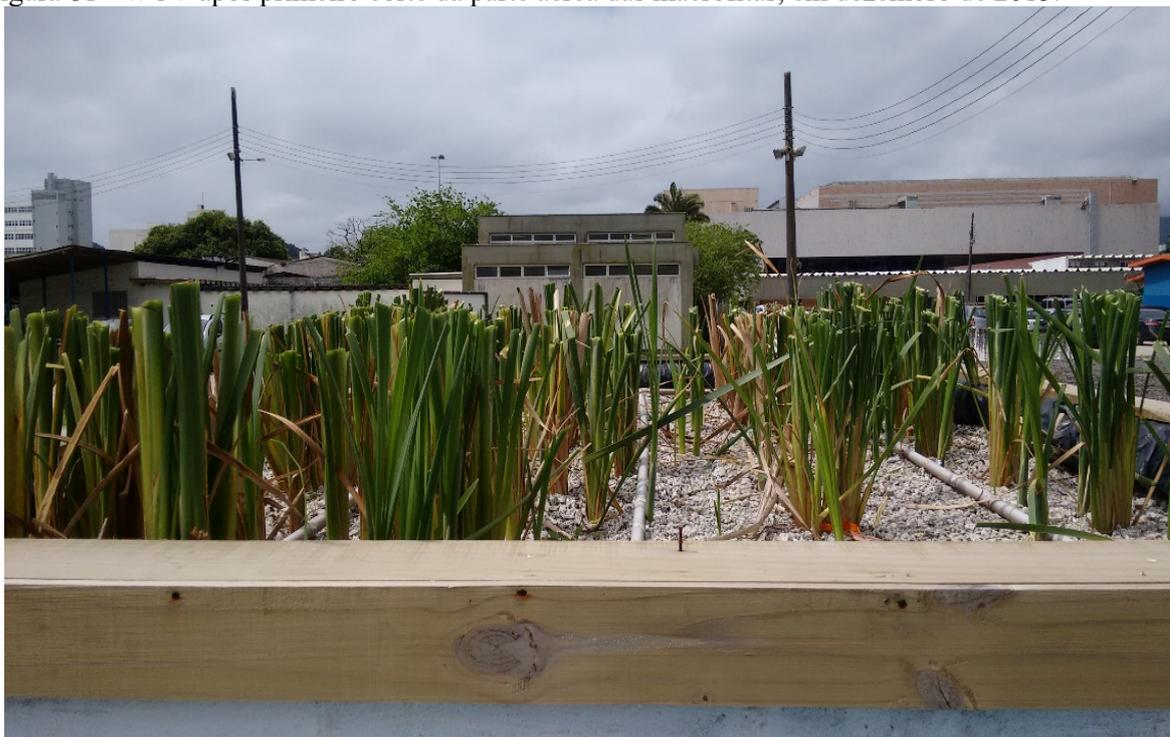
Figura 82 - WCV-FS após primeiro corte da parte aérea das macrófitas, em dezembro de 2015.
