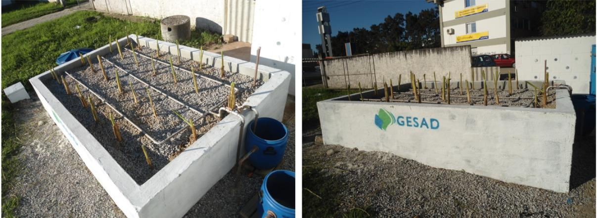
Para manter o fundo saturado, foi inserido um controlador de nível na saída do WCV-FS, correspondendo a 0,40 m de altura em relação ao fundo do wetland construído (Figura 18). Com isso, o WCV-FS permaneceu com 0,35 m de drenagem livre e 0,40 m do leito filtrante saturado com o esgoto submetido ao tratamento.
