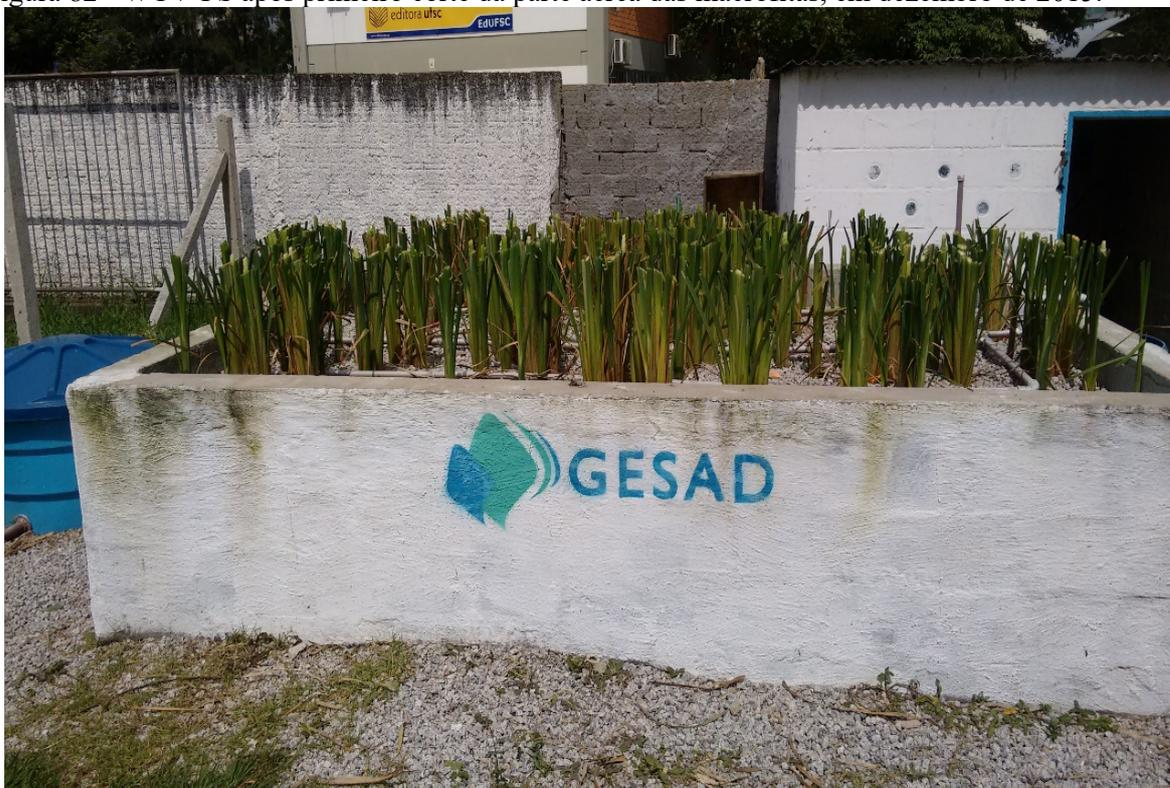
Figura 83 - WCH após primeiro corte da parte aérea das macrófitas, em dezembro de 2015.
