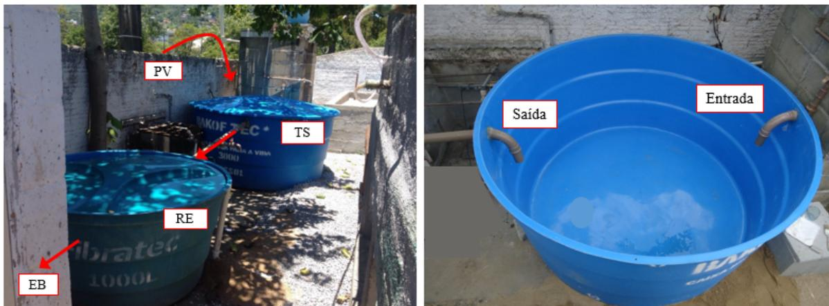
Os reservatórios de passagem R1, R2 e R3, instalados após os três wetlands possuíam 500 L respectivamente. Estes reservatórios não acumulavam esgoto, sendo utilizados somente para operação do sistema. Neles foram inseridos aparatos de medição de vazão e controle de saturação do WCV-FS e WCH.
