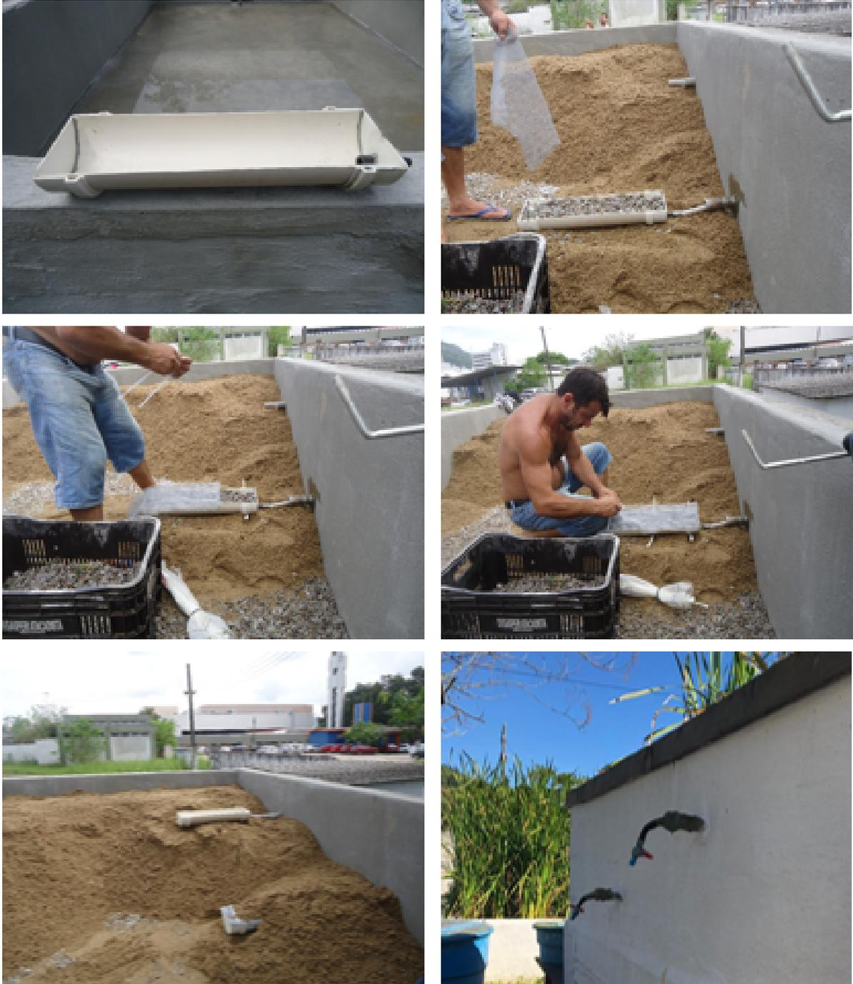
Figura 31 - Amostrador parcial do WCV-FS durante preenchimento do material filtrante da unidade e indicação do local de coleta da amostra parcial, na parte externa do wetland.
