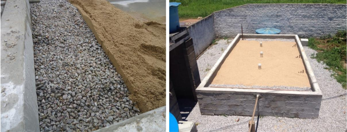
Após a construção e preenchimento dos wetlands com o material filtrante, foram realizados testes hidráulicos utilizando água. Durante os testes observou-se que a impermeabilização do WCV não tinha sido eficiente, pois apresentava sinais de infiltração e vazamento. Dessa forma, todo o material filtrante precisou ser retirado do wetland para proceder com uma nova forma de impermeabilização, que utilizou camadas de lona e manta geotêxtil (Figura 23).
