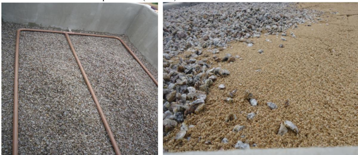
Figura 21 - Detalhes do preenchimento do material filtrante do WCH.
