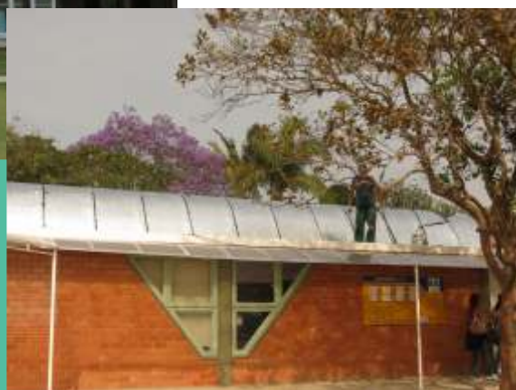
Revestimento telhado do NDI
