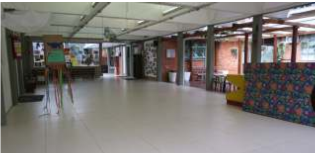
Piso do pátio coberto do Bloco II
