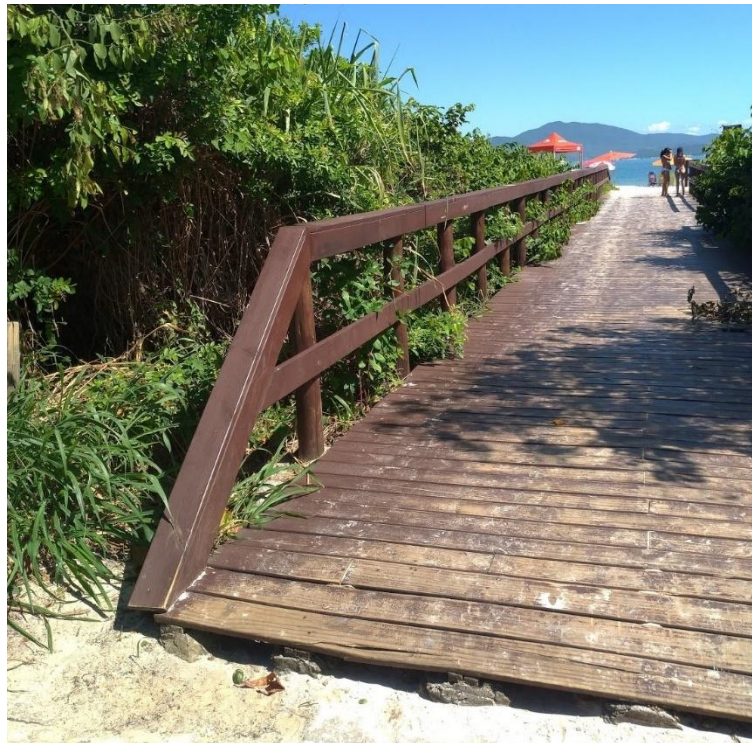
Figura 10: Passarela elevada de acesso à praia.
