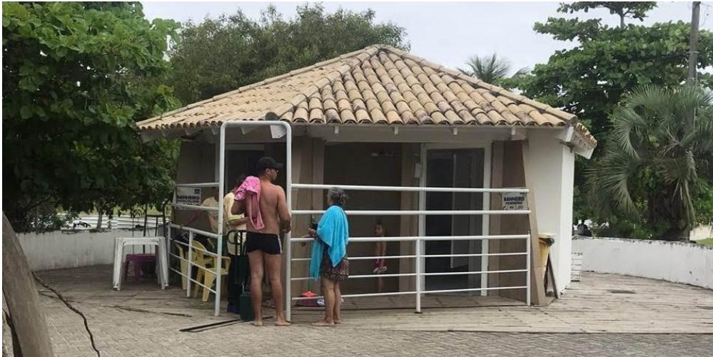
Figura 12: Banheiros na praia de Jurerê Internacional.
