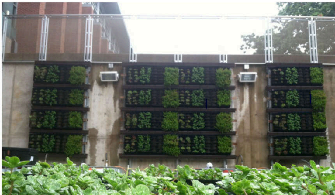
Figura 4-7 - Sistema de paredes verdes.
