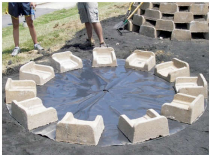
Figura 4-5 - Montagem da estrutura de paredes verdes circular.
