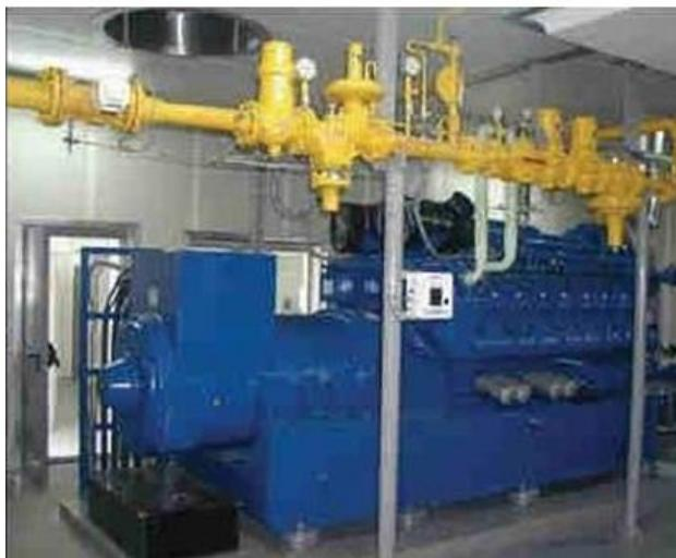
Figura 10- Motor de combustão interna operando num sistema de cogeração.
