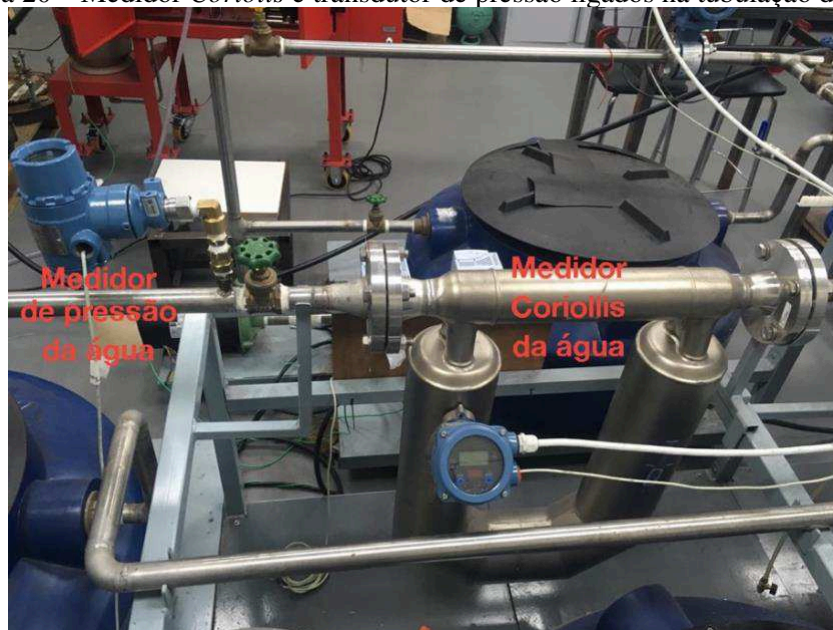
Figura 20 – Medidor Coriolis e transdutor de pressão ligados na tubulação de água.
