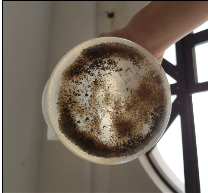
Figura 36: Quantidade de material depositado no bocal, após desobstrução
