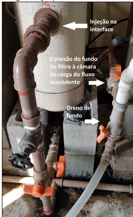
Figura 10: Imagem da porção inferior do filtro e suas conexões
