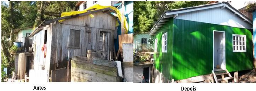
Figura 10: Imóvel residencial antes e depois da melhoria estrutural
