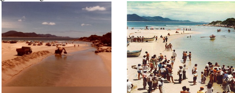
Figura 71: Registro de abertura mecânica da barra do canal na década de 1970.
