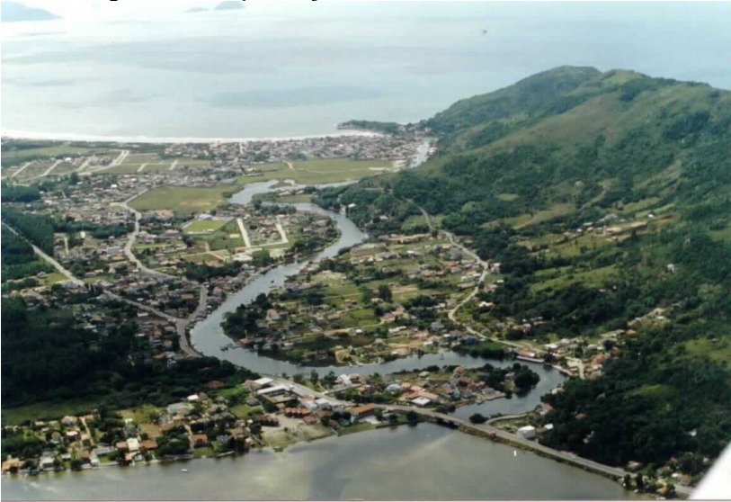
Figura 69: Fotografia aérea oblíqua, com panorama geral da área do Canal da Barra da Lagoa da Conceição e adjacências, ilha de Santa Catarina, SC.
