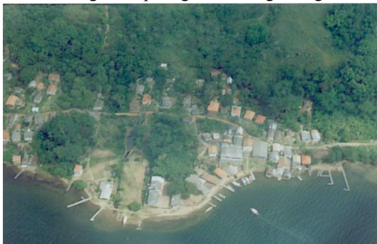
Margem antropizada na Costa da Lagoa (perfil A-A')
