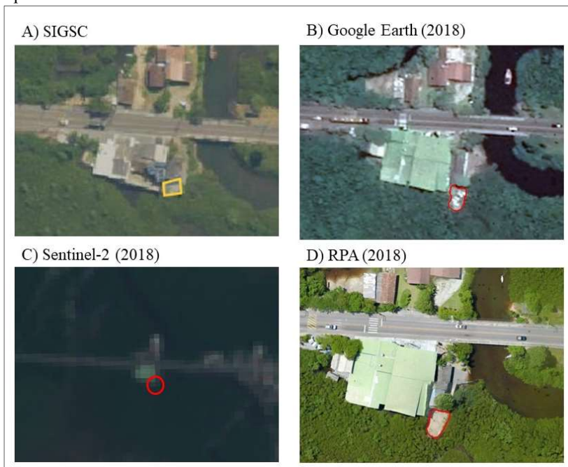
Figura 18 - Local da infração de construção em área de preservação permanente a partir de diferentes ferramentas
