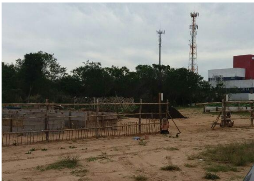
Figura 38: Construção da cerca de bambu.
