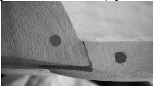
Figura 47 – Detalhe dos buracos dos pregos na canoa CI
