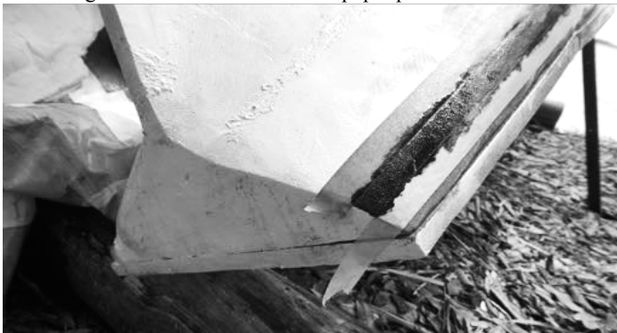
Figura 53 – Detalhe da fita de papel para limitar riscas
