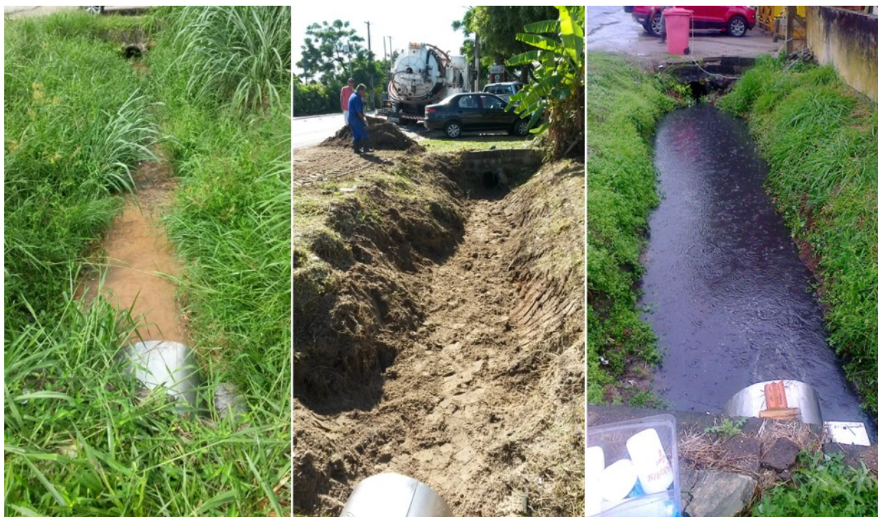
Figura 4-2. Vala de infiltração em diferentes estágios.
