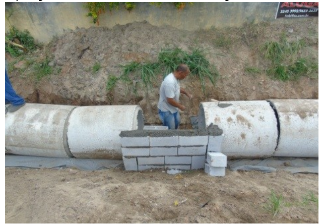
b) Colocação dos tubos perfurados e construção das caixas de inspeção.
