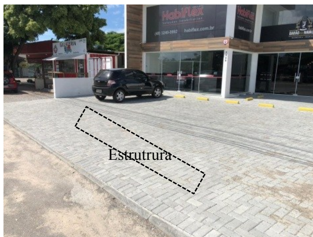
e) Estrutura finalizada – indicação da localização da vala modificada
