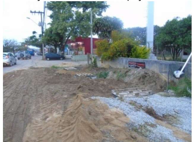
d) Finalização temporária da vala modificada.
