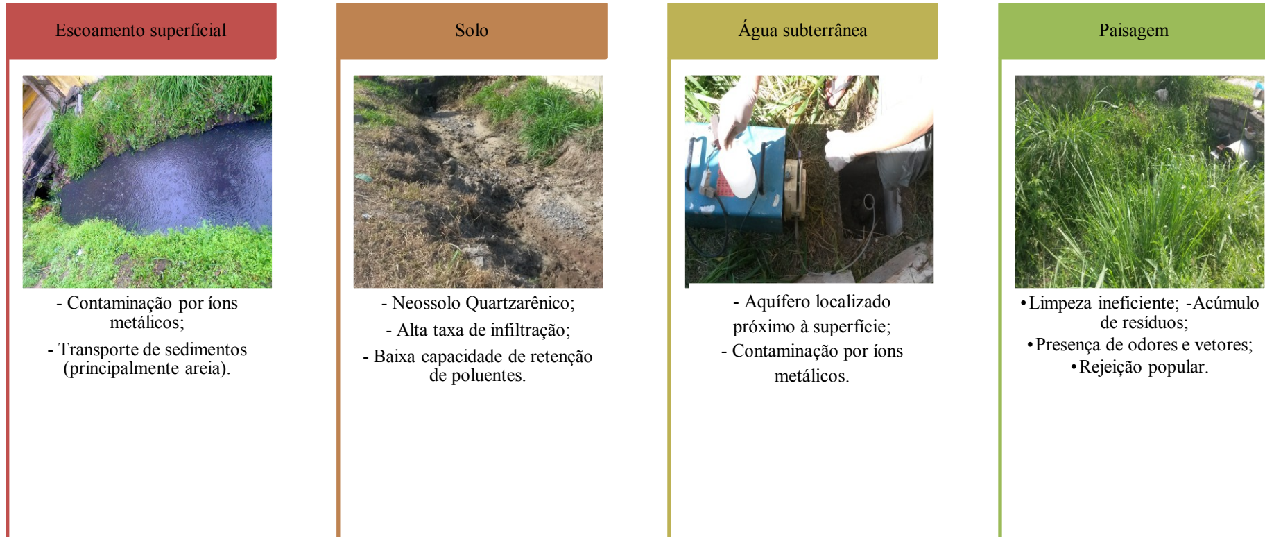
Figura 4-24 – Resumo das condições em que se encontra a vala de infiltração.
