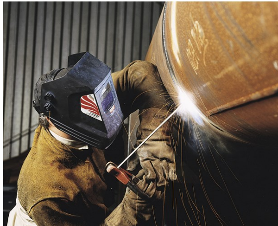
Figura 1 - União de dutos executada de forma manual via processo de soldagem por eletrodo revestido (SMAW). (Fonte: [5])
