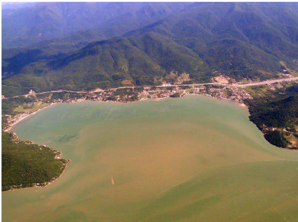
Imagem 20: Vista aérea da Enseada de Brito. Vê-se ao fundo a Serra do Tabuleiro e logo abaixo dela o traçado da Rodovia Federal BR-101. Fonte: SANTOS (2018).
