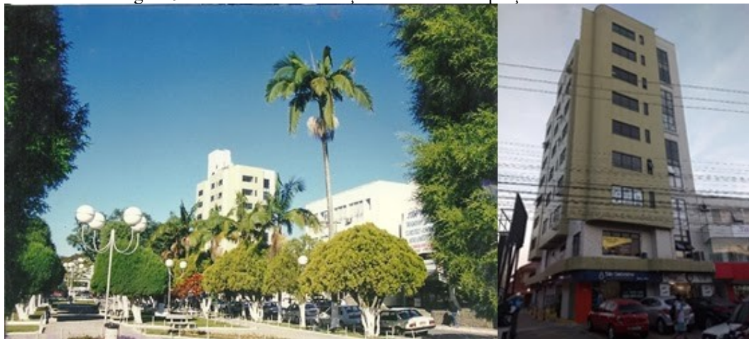
Figura 9 - Início da verticalização no entorno da praça central
