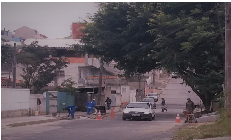
Figura 12 - Trabalhando na rede de Saneamento Básico do bairro Bela Vista São José/SC.
