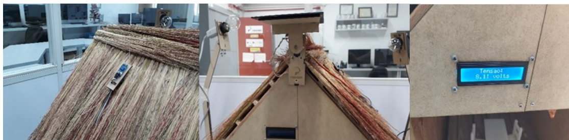
Figura 33: Detalhes da instalação eletroeletrônica da cabana
