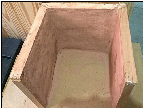
Figura 30: Barreamento das paredes da cabana
