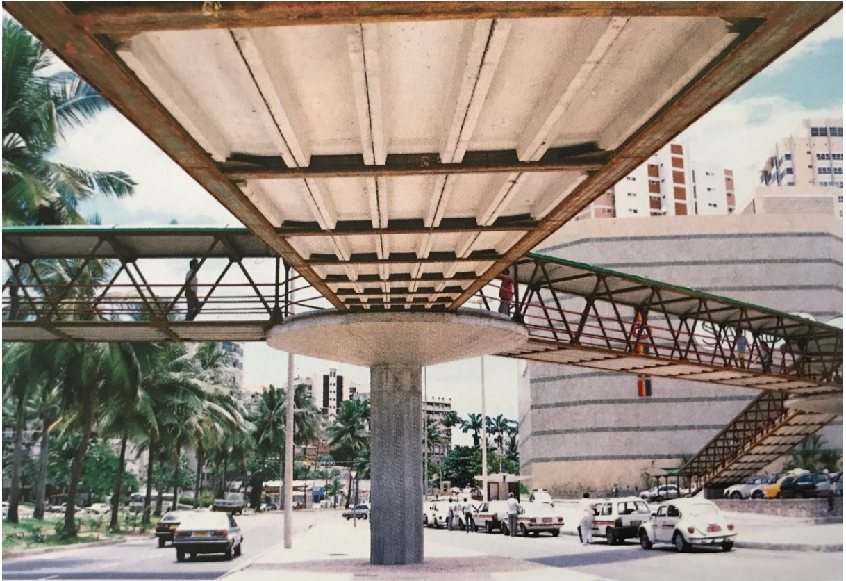
Figura 36: Passarela Chame-Chame, Salvador
