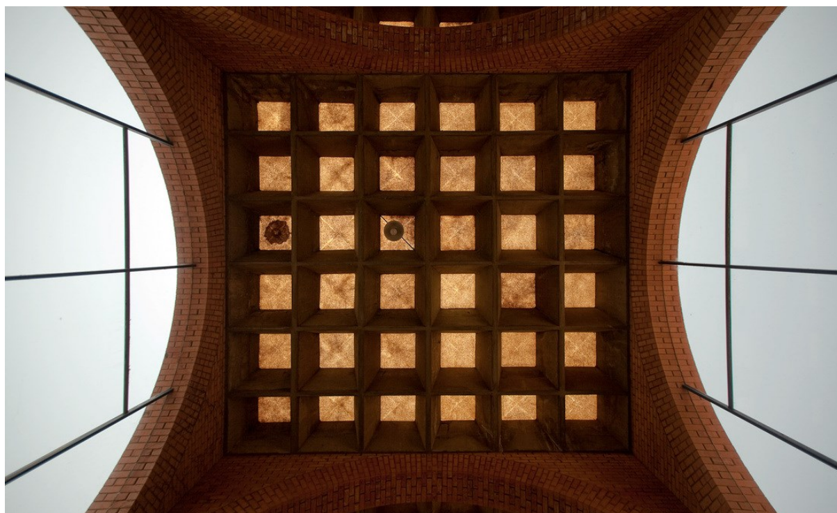
Figura 90: Residência Nivaldo Borges, laje nervurada
