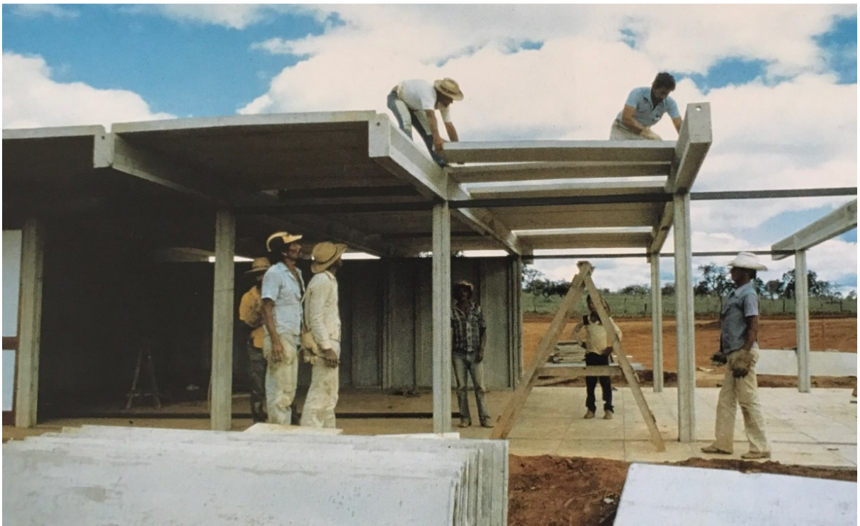
Figura 29: Escola Transitória Abadiânia, construção
