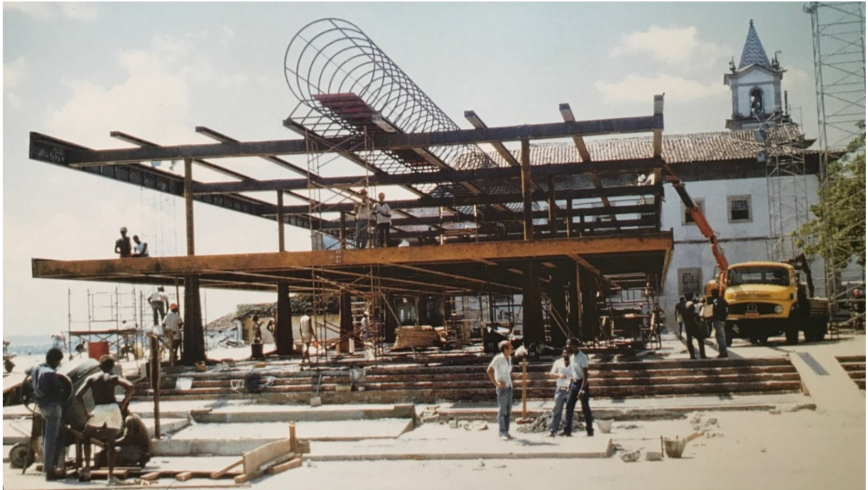
Figura 40: Palácio Thomé de Souza, montagem da estrutura
