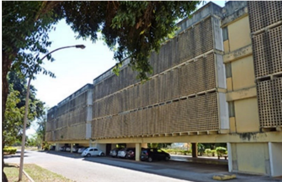
Figura 21: Conjunto Colina, cobogós
