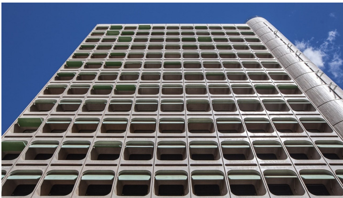
Figura 27: Edifícios Camargo Corrêa
