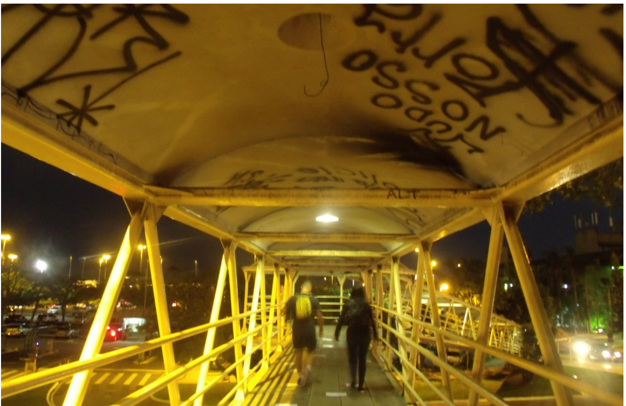
Figura 38: Passarela da Rodoviária, Florianópolis
