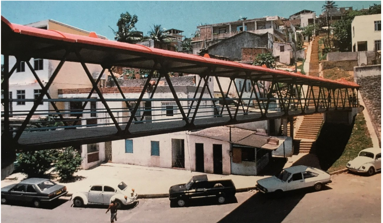
Figura 37: Passarela Bonocô, Salvador
