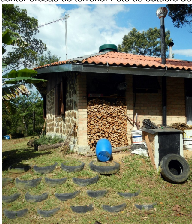
Figura 93 – Técnicas: casa (zona zero) bioconstruída com diferentes técnicas adequadas ao contexto local: cordwood na parede da esquerda. Na face voltada para oeste – lado mais quente e seco – armazenamento de lenhas e parte externa do banheiro seco (sanitário compostável) com chaminé eólica. Escada de pneus para conter erosão do terreno. Foto de outubro de 2013.
