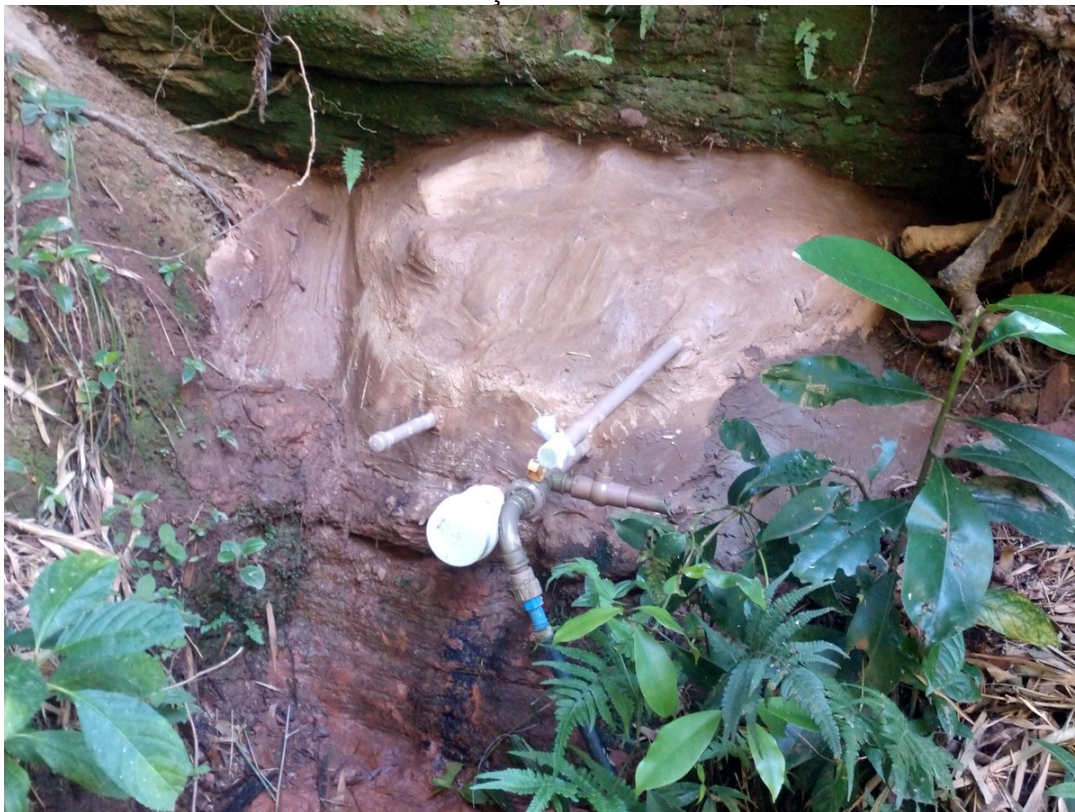
Figura 148 – Técnica: proteção de fonte/nascente de água tipo caxambu. Foto de março de 2019.
