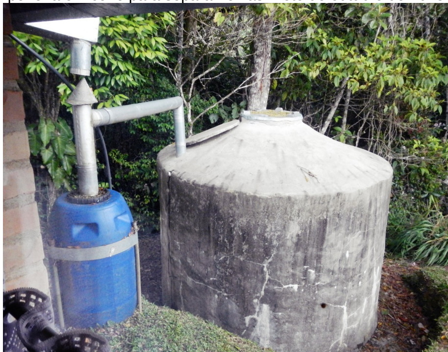
Figura 94 – Técnicas: Cisterna para captação de água da chuva, principal fonte deste recurso nesta unidade, com detalhe para separação das primeiras águas e peneira em cone para separar folhas. Foto de outubro de 2013.
