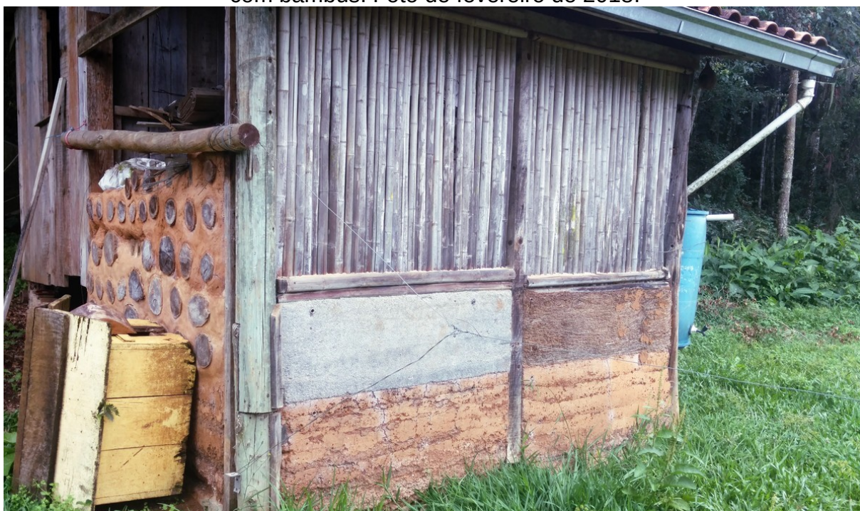
Figura 106 – Técnicas de bioconstrução no sítio parceiro, de parede em estrutura didática: cordwood , taipa de pilão com solo, cascas de arroz e palha, preenchimento com bambus. Foto de fevereiro de 2018.
