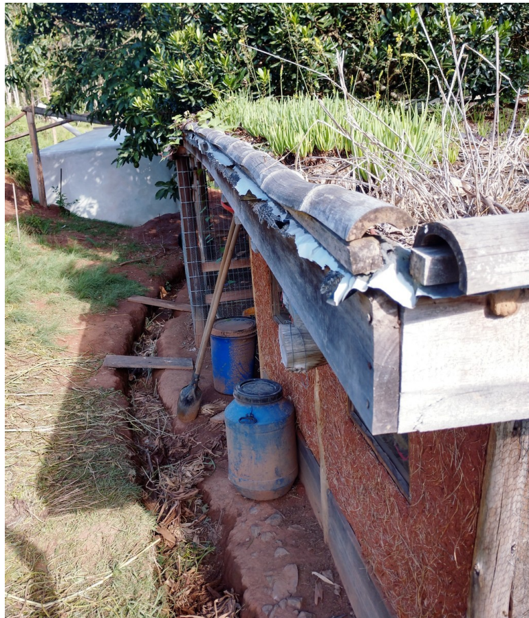
Figura 146 – Técnicas: galinheiro bioconstruído com paredes de barro e telhado verde e ao fundo cisterna de captação de água da chuva. Foto de março de 2019.
