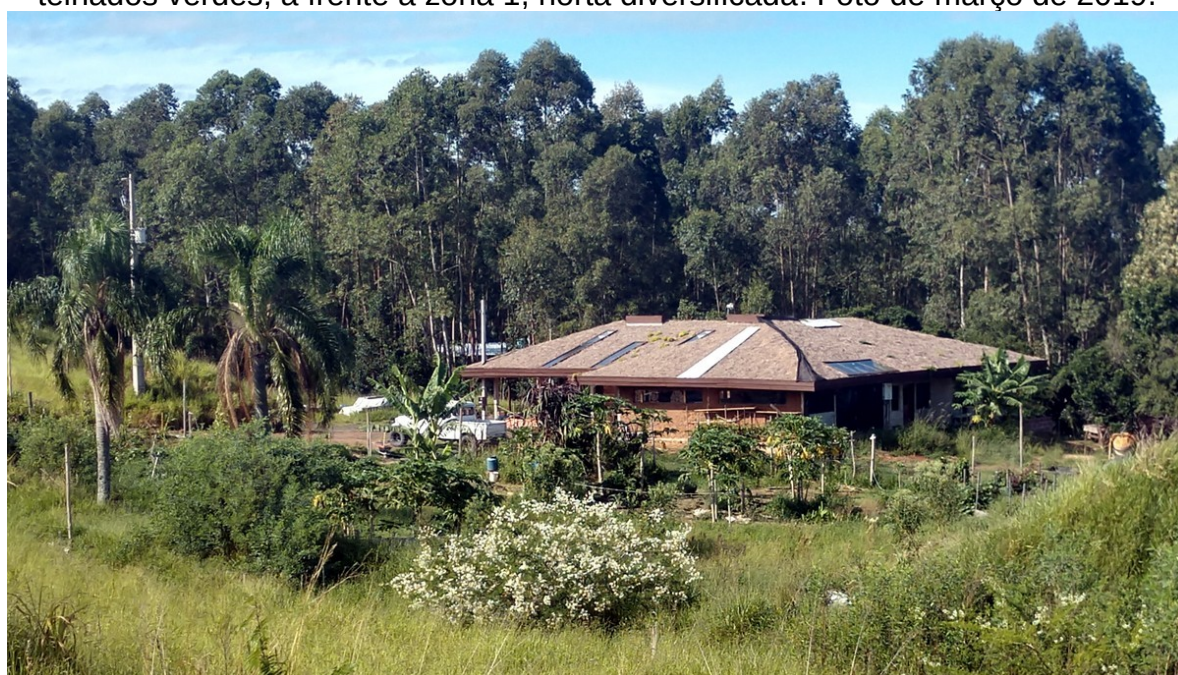
Figura 145 – Elementos: casa (zona 0) bioconstruída com paredes de barro e telhados verdes, a frente a zona 1, horta diversificada. Foto de março de 2019.
