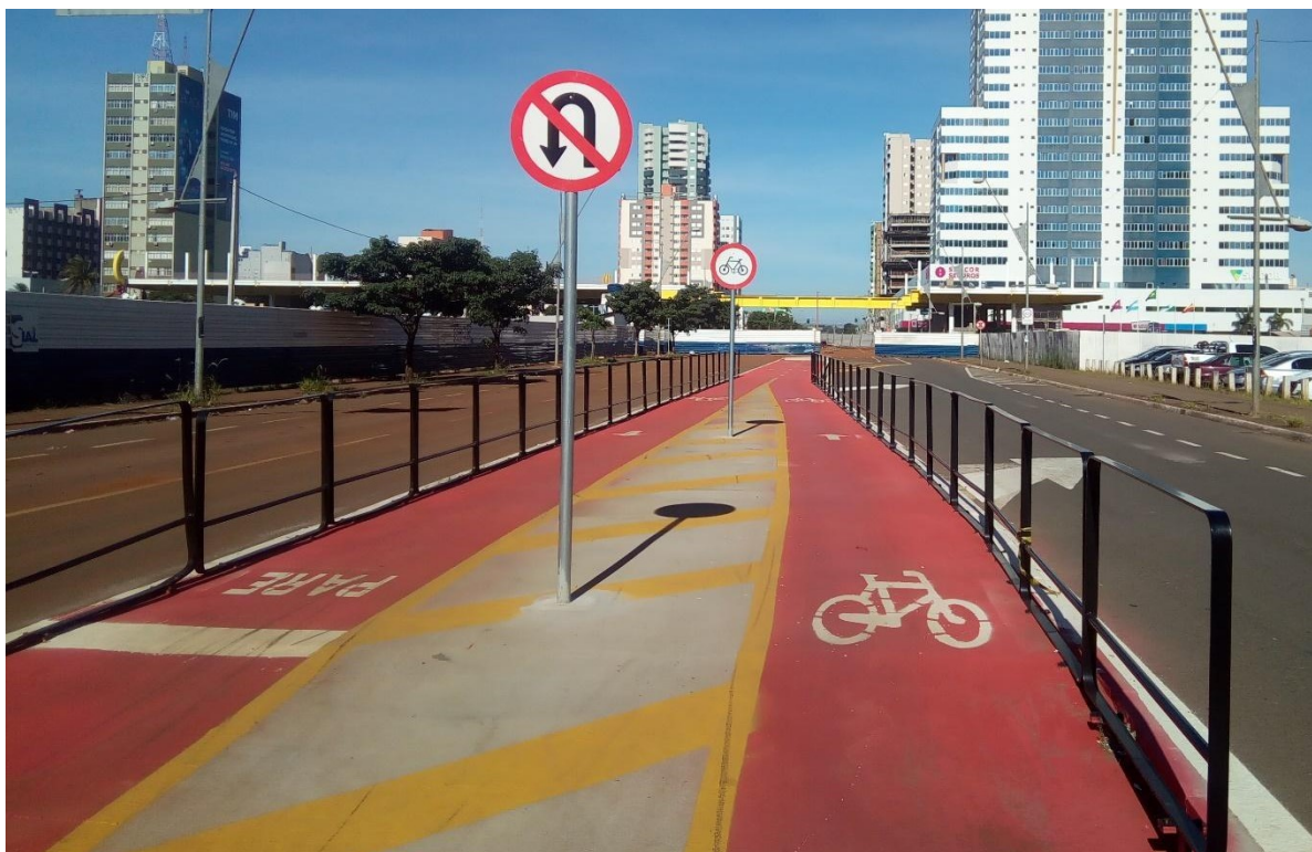
Figura 26 - Ciclovía da Avenida Horácio Racanello, próximo à construção do Terminal Intermodal.
