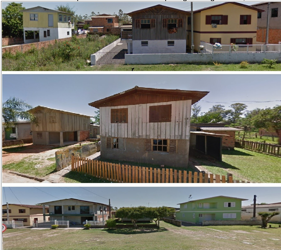
Figura 29: Exemplos de adaptações às enchentes no Bairro Barranca, em Araranguá. Trabalho de Campo de reconhecimento da paisagem. Org. Ribeiro, 2019.
