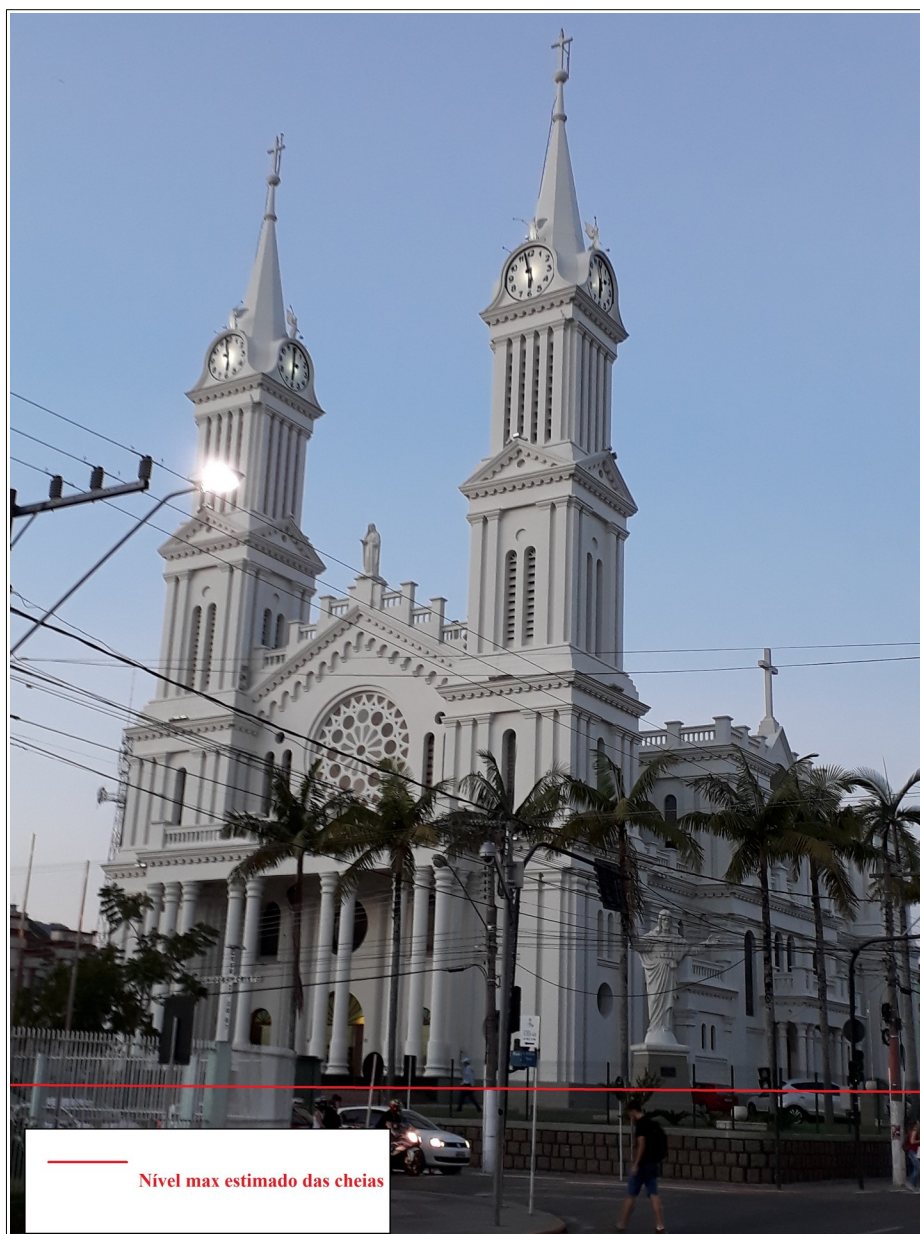
Figura 28: Igreja Matriz de Rio do Sul, nível de sua construção estimado conforme o histórico das cheias no passado mais distante, exemplo já à época das adaptações dos rio-sulenses às enchentes.
