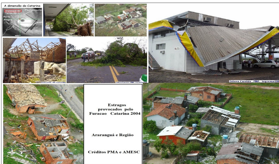
Figura 51: Estragos provocados pelo Furacão Catarina, Araranguá e região.
