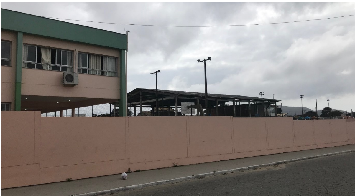
Figura 2 – Infraestrutura externa da escola (vista para as quadras)
