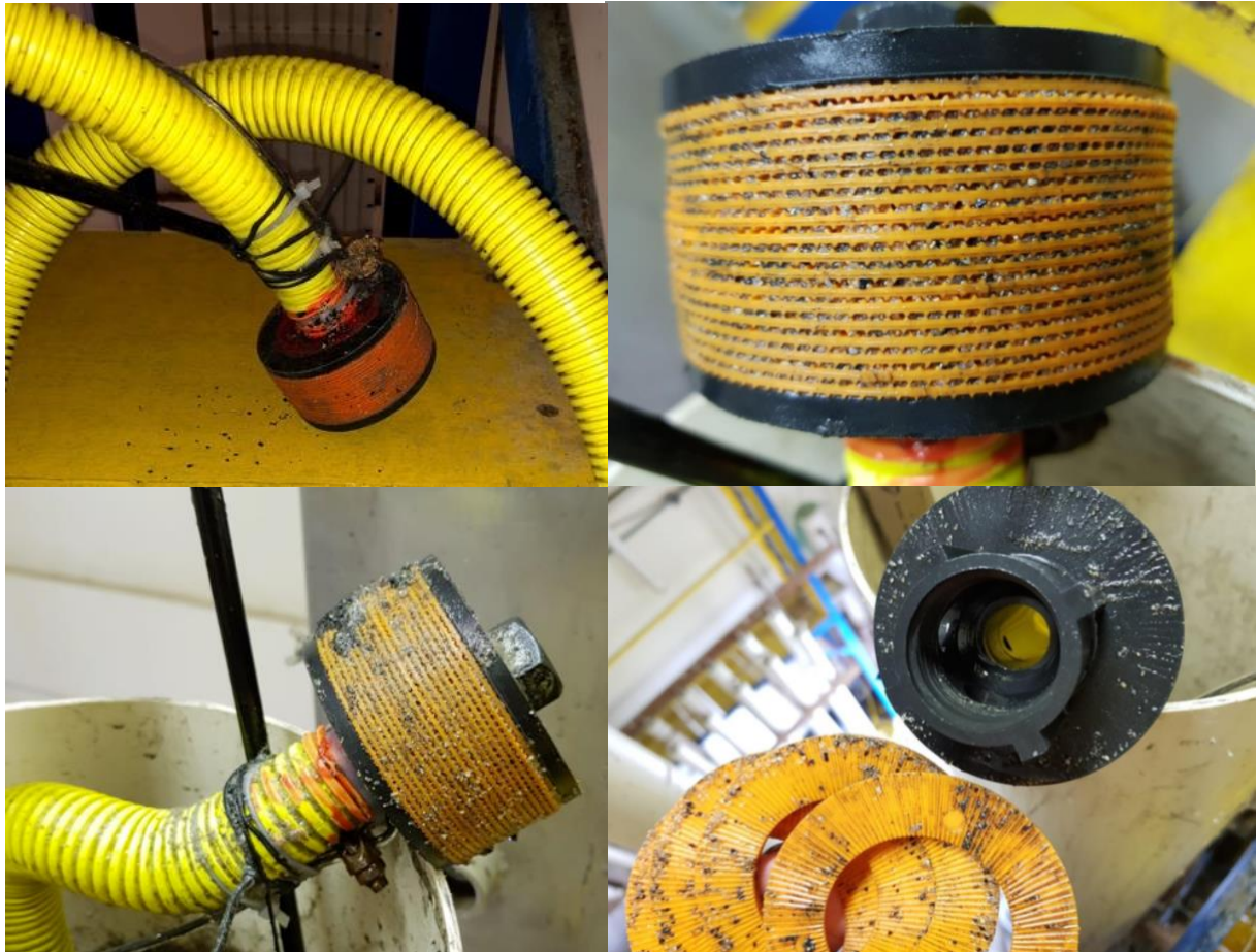
Figura 22, 23, 24 e 25 - Crepina em procedimento de limpeza.
