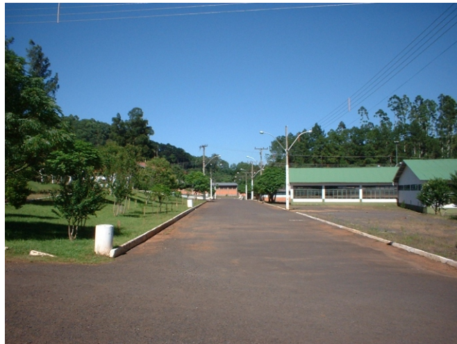
foto 07- vista da rua interna asfaltada do Parque. Inexistência de passeios e mobiliário urbano.
