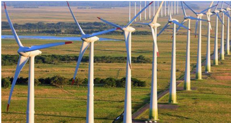
Figura 2 Parque eólico onshore
