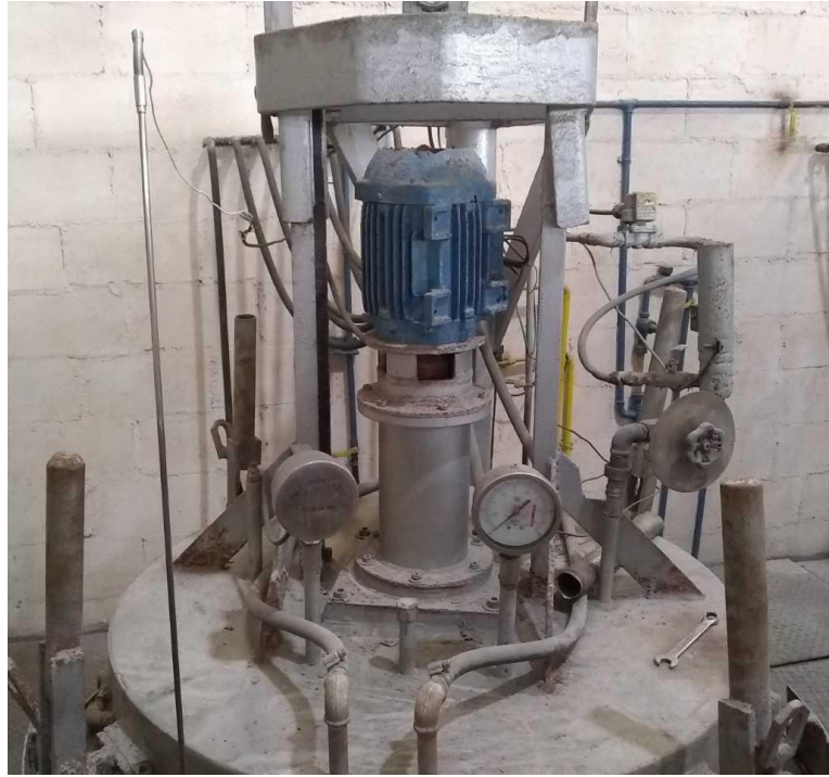
Figura 37: Forno utilizado para tratamento térmico de alívio de tensões.
