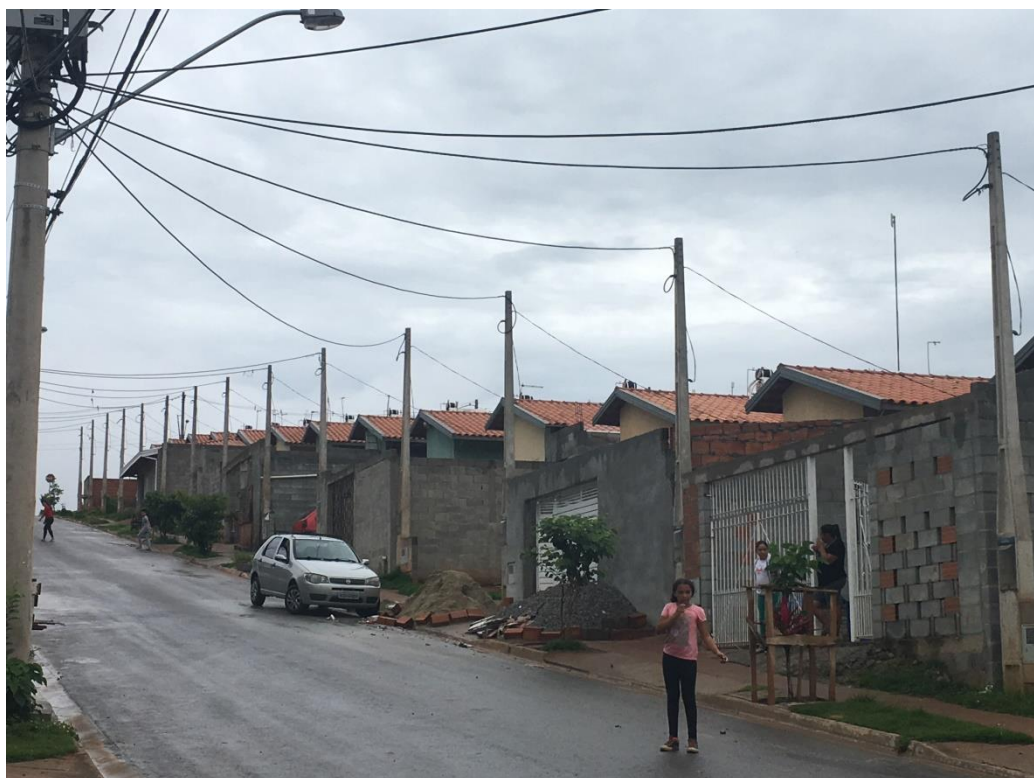
Figura 6 - Sistema de Medição Centralizada em Mogi das Cruzes - SP
