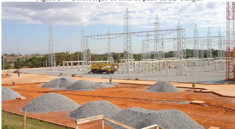
Figura 27 – Distribuição de brita no pátio da SE-Carajás.
